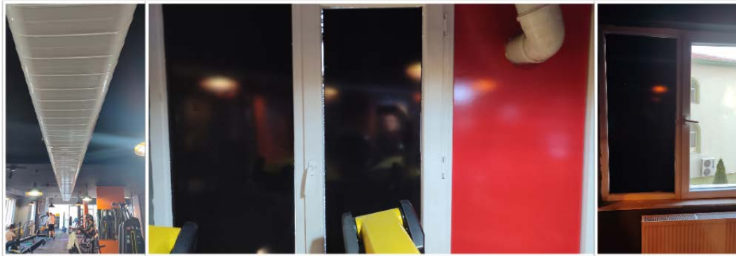
Şekil 16. Havalandırma ve Pencere yapıları.
