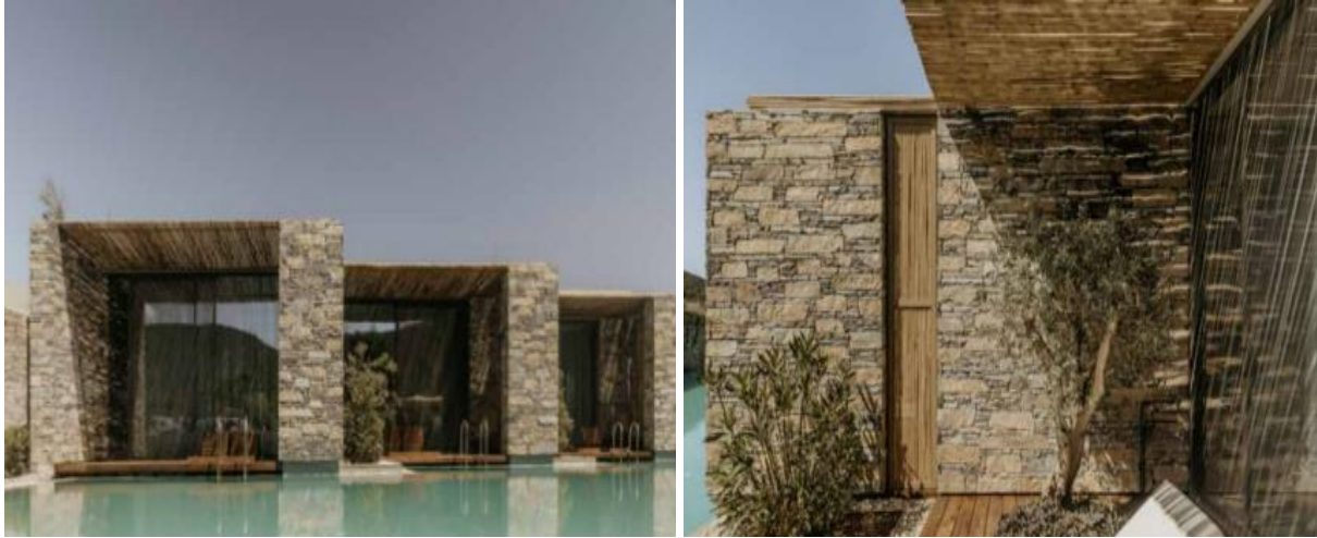
Şekil 5. Granit malzemeyle yapılmış dış cephe kaplama uygulamaları (URL 6)
