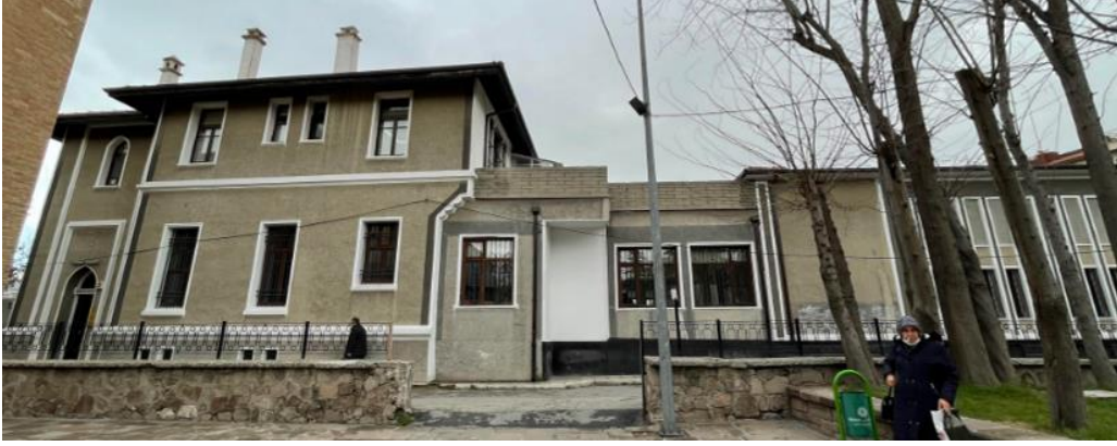
Fotoğraf 23. Yapının Batı Cephesinin Görünüşü
