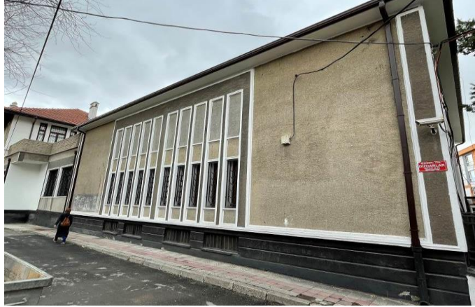
Fotoğraf 25. Yapının Batı Cephesinin Görünüşü
