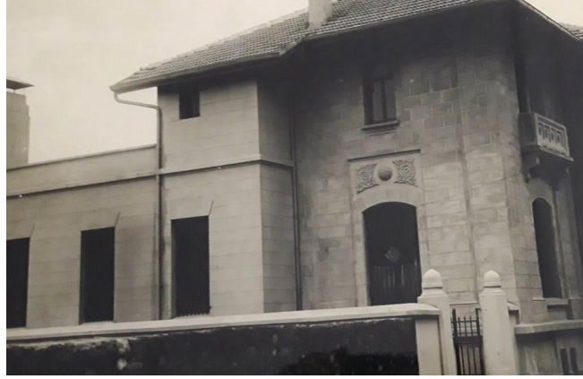
Fotoğraf 21. Yapının Doğu Cephesinin Görünüşü (Konya Ziraat Bankası Arşivi)
