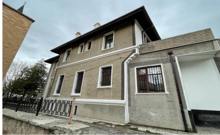
Fotoğraf 26. Yapının Batı Cephesinin Görünüşü
