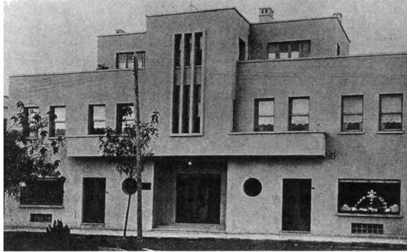
İnhisarlar Tekel İl Müdürlüğü Binası (S. Bozdoğan)
