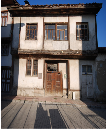
Giriş kapısının görünüşü
