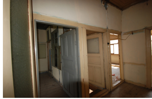
Şekil 22: İç mekân oda kapısı görünüşü
