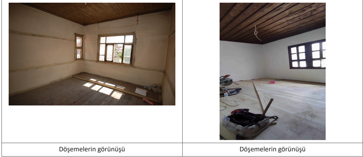
Şekil 27: Emine Tekgöz evinin restorasyon öncesi ve sonrası görünüşleri
