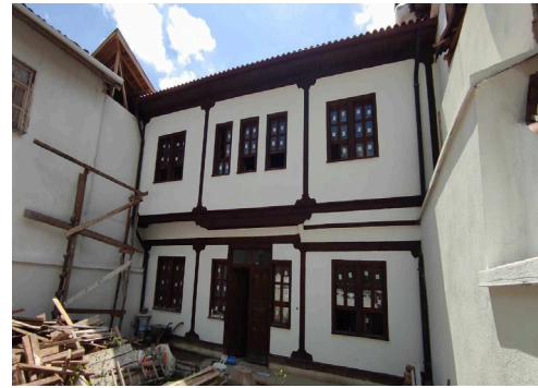
Şekil 14: Evin arka cephesi
