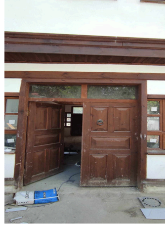
Giriş kapısının görünüşü
