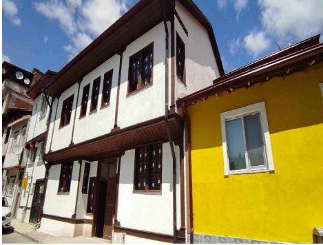
Şekil 13: Evin giriş cephesi
