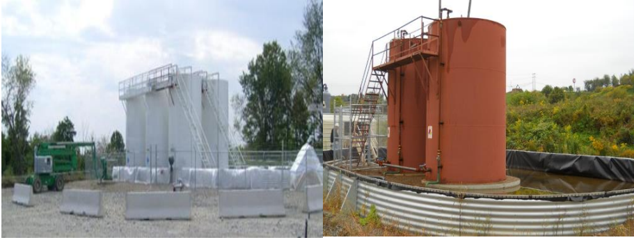
Şekil 6. ABD Kaya Gazı Sahalarında Sondajdan Üretilen Kaya Gazının Depolandığı Tanklar: Marcellus (sol) ve Utica (sağ)
