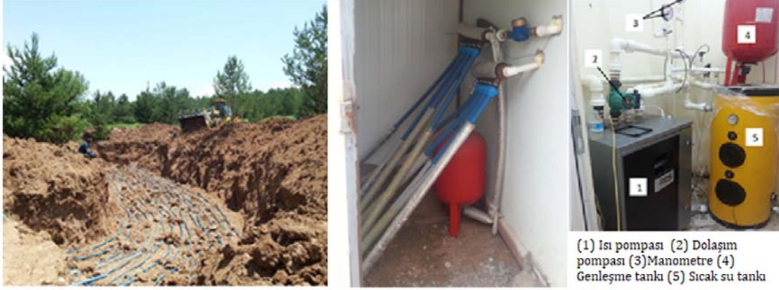
Şekil 3. Sistem elemanlarının resimleri (a) toprakaltına döşenen borular, (b) gidiş -dönüş kolektörleri, (c) ısı pompası bağlantısı
