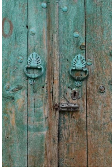
Foto. 2. İhsan Şahin Odası-Giriş Kapısı (Esra G.B.)
