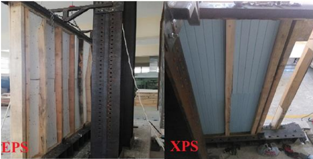
Şekil 3. Perde duvarların yalıtım malzemesiyle kaplanması.
