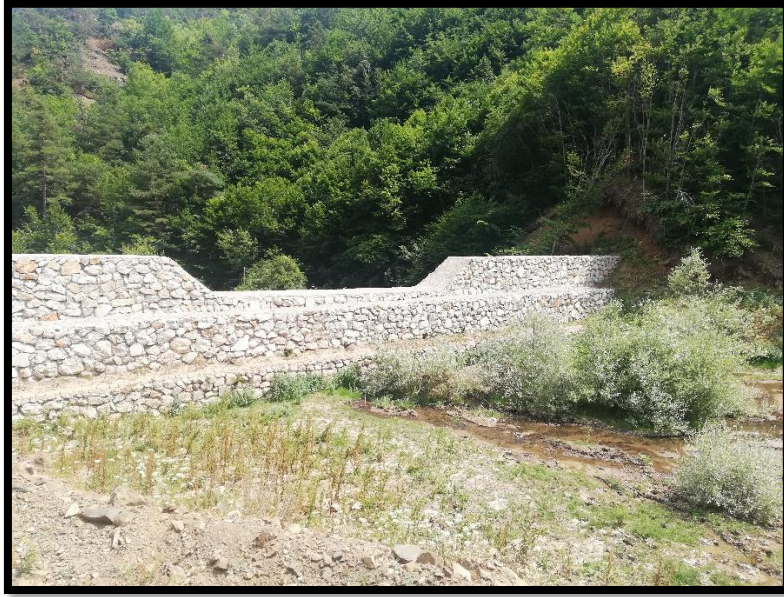
Fotoğraf 2. 1075 m Rakımdaki Gölün Sediman Dolumunu Engellemek İçin Yapılan Set (Uydu Fotoğraflarından Bu Setin 2000 ile 2010 Arasında Yapıldığı Anlaşılmaktadır).
