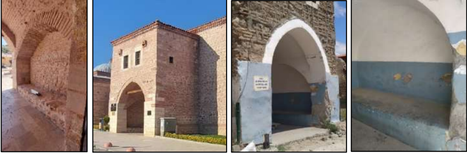
Şekil 39: Restore Edilen Yapının Eyvanlı Giriş Alanındaki Niş Kısımı ile Özgün Taş Kaplaması ve Restore Edilmeden Önce Yapının Eyvanlı Giriş Alanındaki Niş Kısımı ve Boya Tabakası 102
