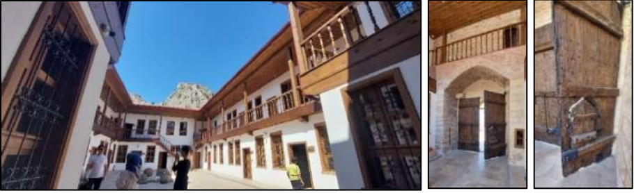
Şekil 36: Restore Edilen Ahşap Malzemeler-Orijinal Ahşap Giriş Kapısı 99
