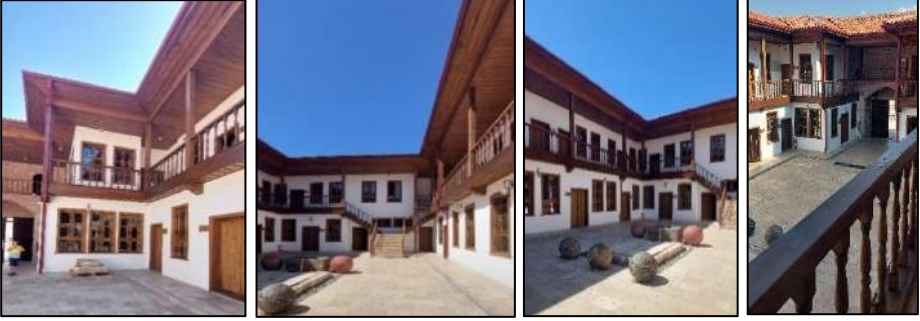
Şekil 35: Restore Edilen Yapının Orijinal Giriş Kapısı ve Avlu Kısım 98
