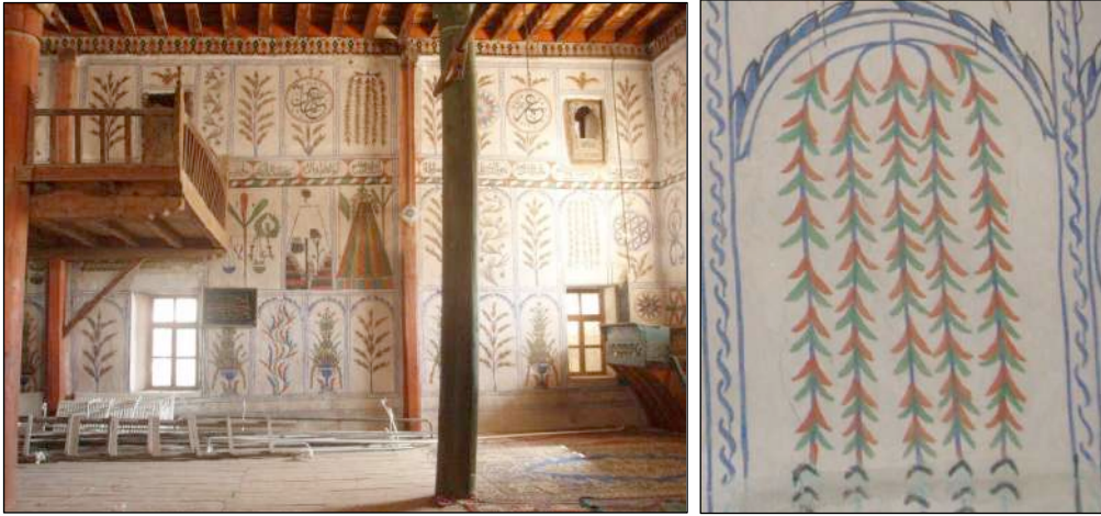
Resim 14 a-b: Söğüt Dalları Tasviri, Denizli Baklan Boğaziçi Camii, Doğu Duvar, 1774-1775 Tarihli (Tuğçe Yurtsal, fot. 241).
