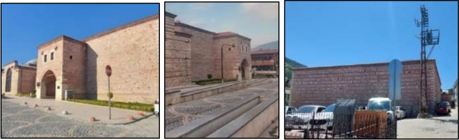
Şekil 37: Restore Edilen Yapının Özgün Taş Duvarları 100
