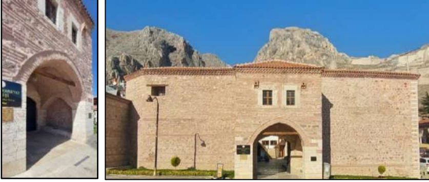
Şekil 24: Yapının Güney Cephesinde Eyvan Tarzındaki Taç Kapısının Sağ Üst Kısmında Saçak Altında Tuğla Malzemeden Yapılan Kuş Evi 83
