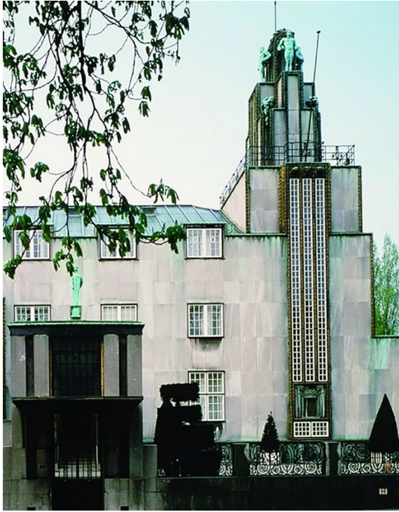
Şekil 4a. Stoclet Palas Kuzey Cephe Merdiven Kulesi (UNESCO, 2009b)
