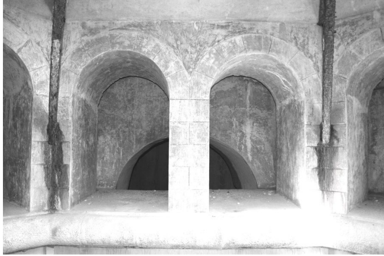
Şekil 19. Su Dağıtım Yapısı, Zemin Altı Yapısı -4.14 kotu yarım daire profilli ikili kemer (Özlen, 2006)
