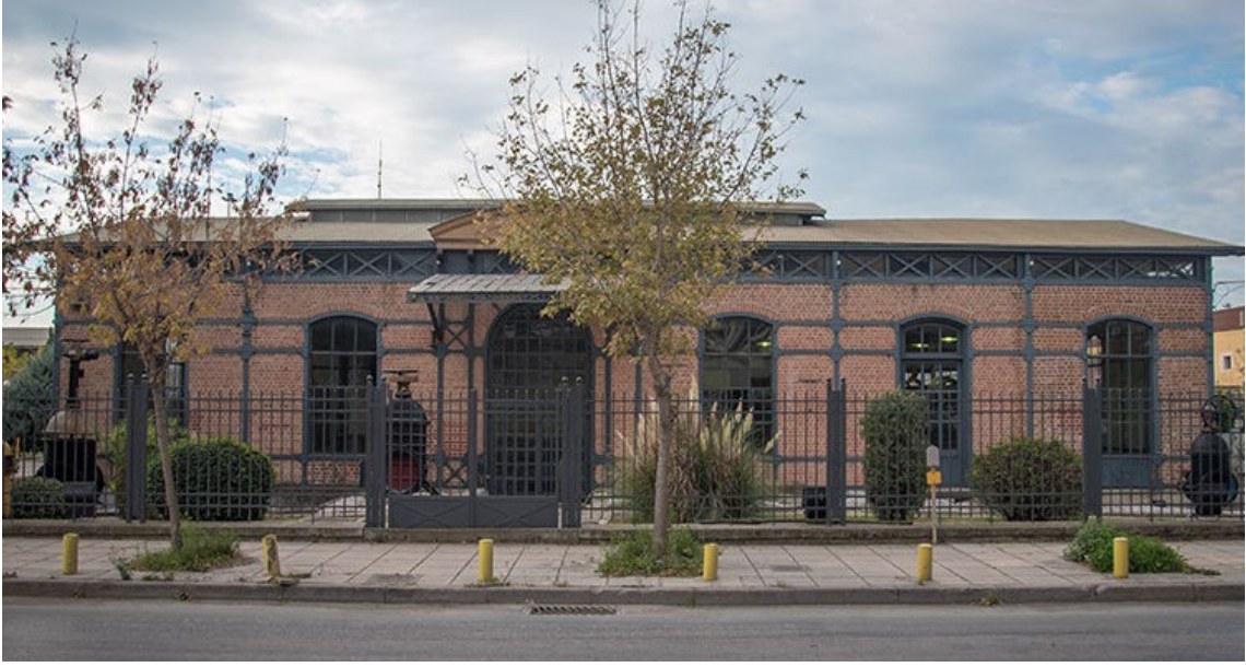
Şekil 21. Selânik Su Pompa İstasyonu (Selânik Su Müzesi) (URL 1)
