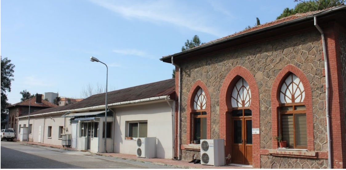
Şekil 14. Laboratuvar binası güney cephesi (Fotoğraf: Şener 2019)
