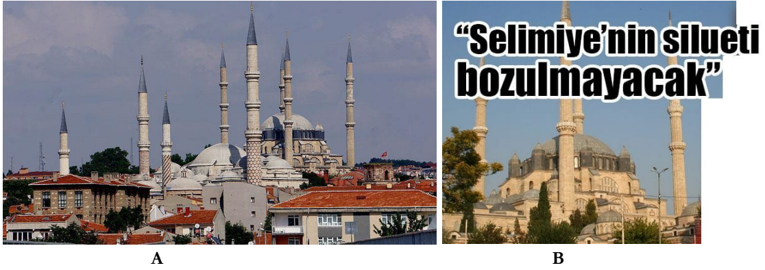
Şekil 21. Selimiye Camii görünürlüğü azaltan yapıların silüet etkisi, 2016 (A) (Url-39) ve (B) (Url-40).
