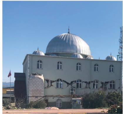
Şekil 34 - İbadethanelerde gözlemlenen taşıyıcı ve taşıyıcı olmayan yığma duvar hasarları
