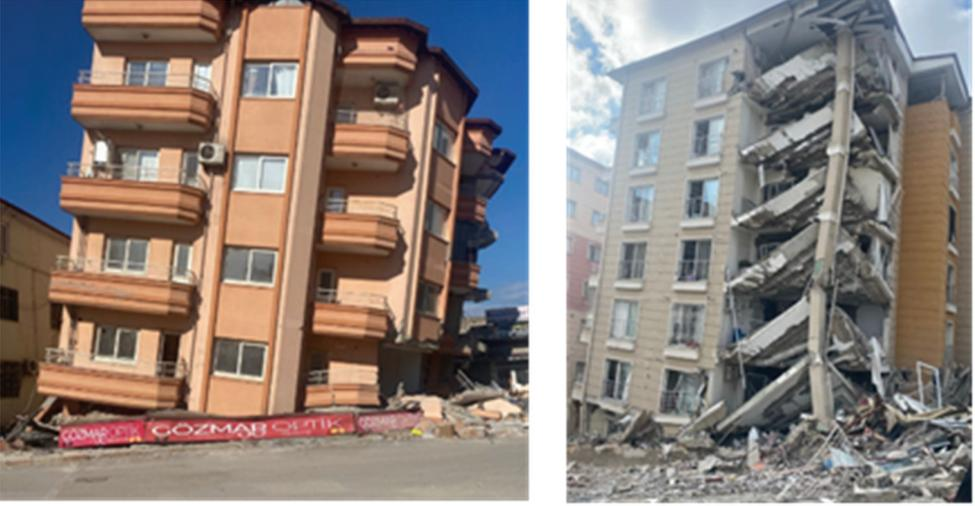
Şekil 23 - Hatay'ın Kırıkhan ilçesinde yumuşak kat hasarı ve binalarda toptan göçme
