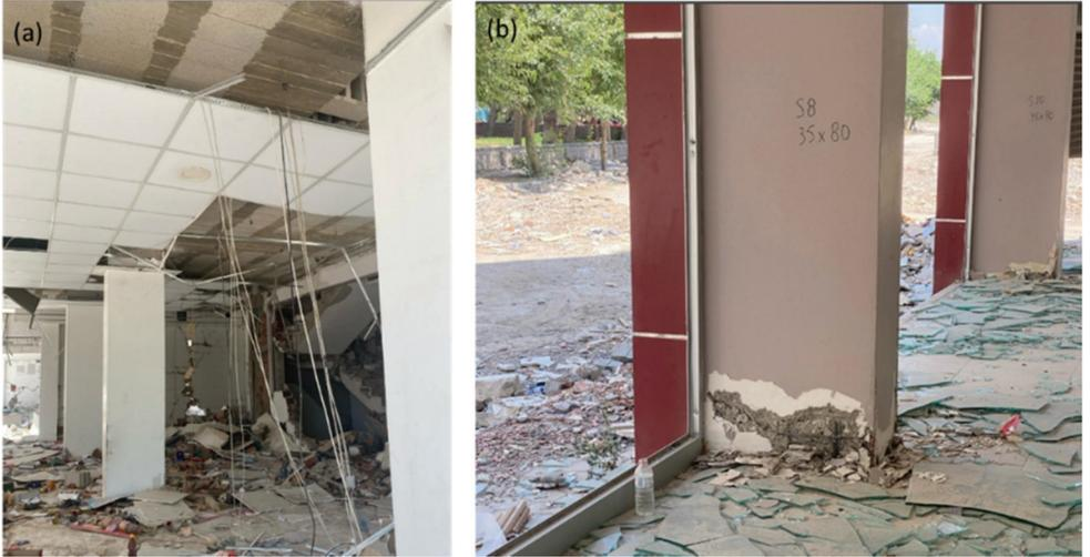
Şekil 26 - (a) Asmolen döşeme hasarı (b) Yapısal düzenleme sonucu oluşan kolon hasarı
