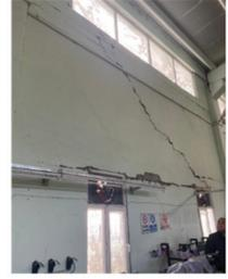
Şekil 38 - Antakya OSB içerisinde yapısal sistemi çelik olan hasarsız üretim tesisi ve depremde elemanları hasar almış olan precast endüstriyel tesis
