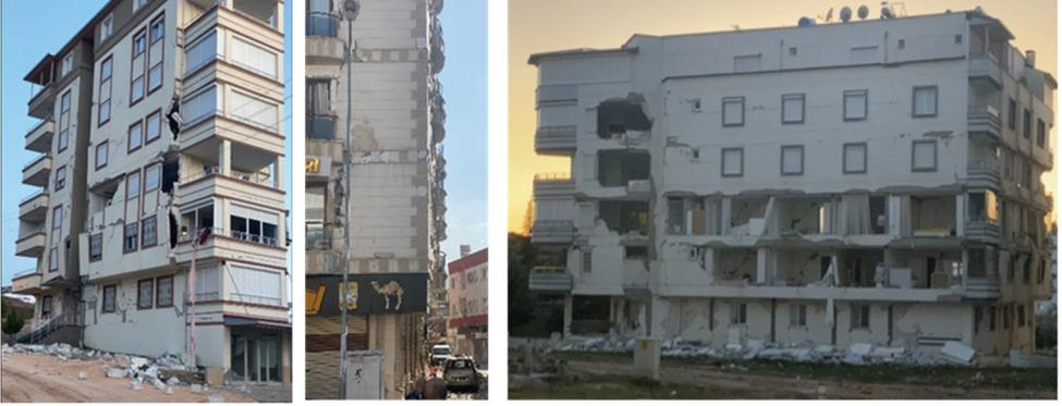
Şekil 19 - Dolgu duvarların düzlem dışı davranışına bağlı yapısal olmayan hasarlar
