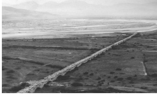
Görsel 2. Alakır Kırkgöz Köprüsü
