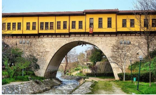
Görsel 8. Irgandı Köprüsü (Bursa)
