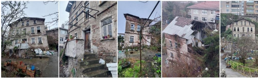
Görsel 36. Süleymanlar Mahallesi'nde kâgir konut.
