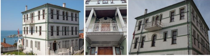
Görsel 28. Halil Paşa Konağı.
