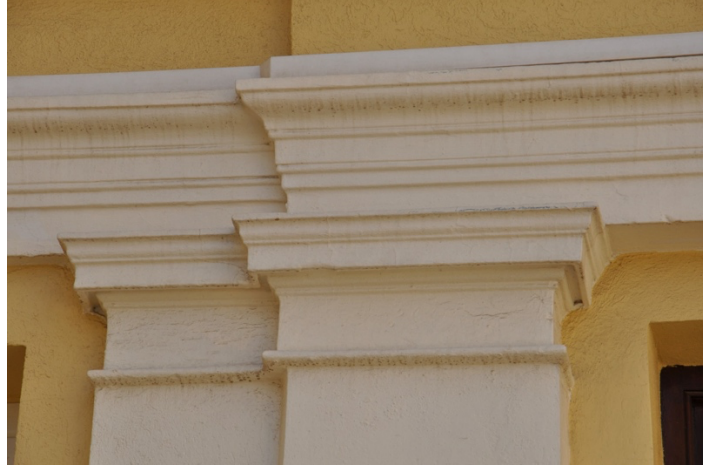
Şekil 65. İzmir Atatürk Lisesi, doğu cephe, profilli pilastr başlıkları, detay
