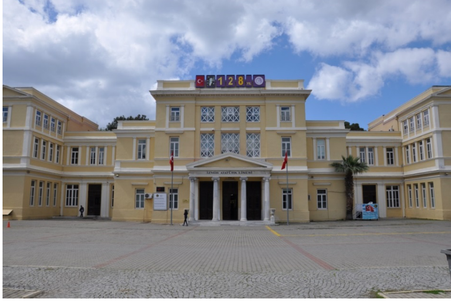
Şekil 45. İzmir Atatürk Lisesi, doğu cephe, doğudan görünüş
