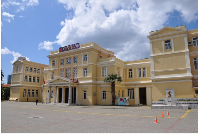
Şekil 44. İzmir Atatürk Lisesi, doğu cephe, kuzeydoğudan görünüş
