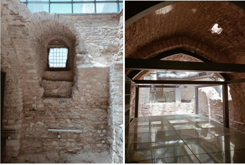
Şekil 16: İç mekân aydınlatma elemanları (Neşe Karaçay, 2021)
