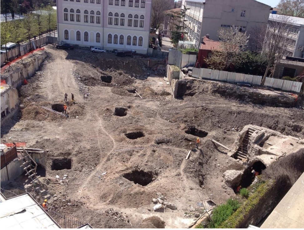
Şekil 1: Temel kazısı sırasında sahanın yaklaşık kuzey batı sınırında, arkeolojik değerler için araştırma çukurları (İstanbul Üniversitesi Yapı İşleri ve Teknik Daire Başkanlığı Arşivi)
