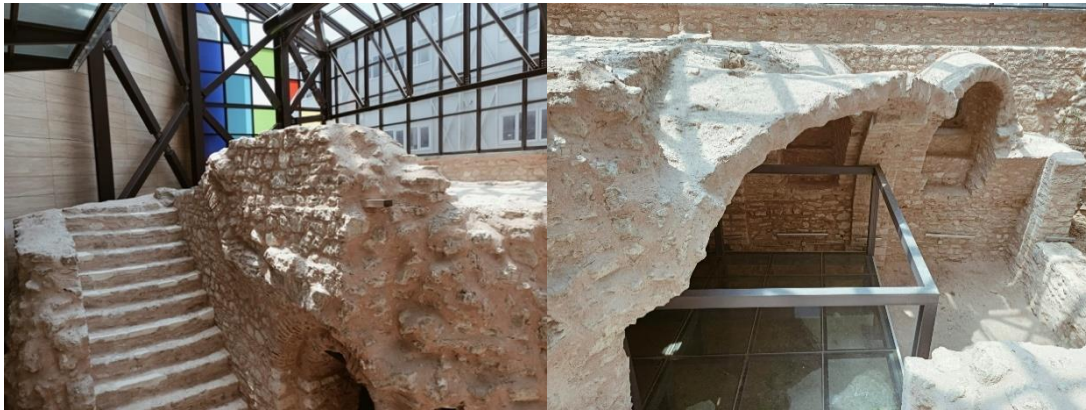
Şekil 18: Arkeolojik değer yer aldığı cam cephe ve iç mekânda cam döşeme detayı (Neşe Karaçay, 2021)
