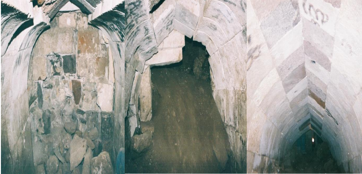
Şekil 34-36. Kale Alt Sarnıcı İç Mekân Şah Kemer ve Tonoz Görünüşleri (Kaynak: Ş. Öztürk, 1996)
