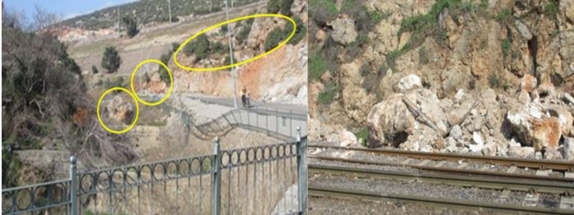
Şekil 16. Fevzipaşa tren istasyonunda kaya düşmeleri [11]
