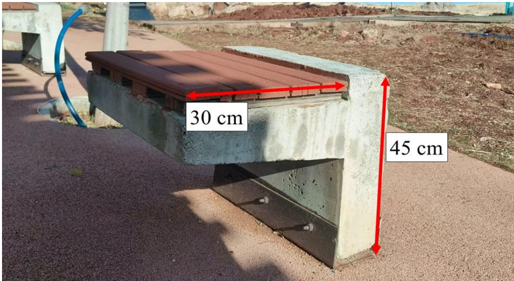
Şekil 13: Oturma elemanı ölçüleri (Orijinal, 2023).
