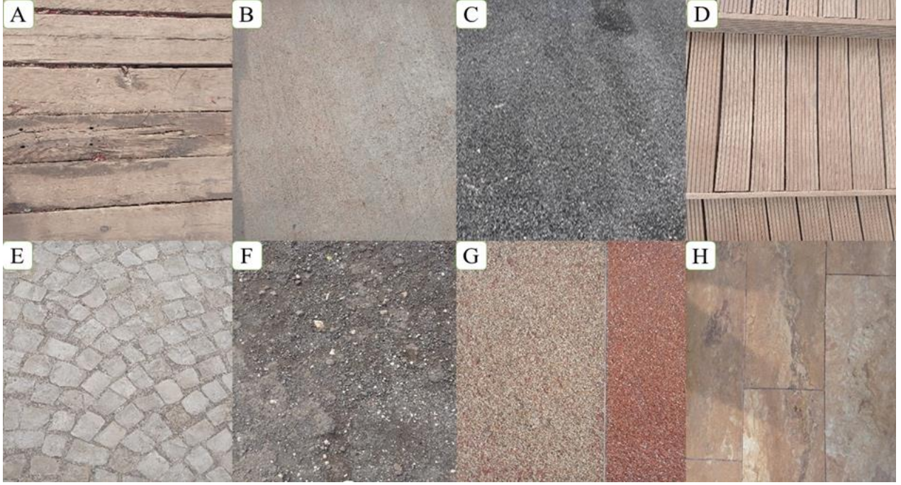
Şekil 4: Göbeklitepe Ören Yeri'nde tespit edilen zemin kaplama malzemeleri. A) Ahşap travers, B) Asfalt beton, C) Bitümlü sıcak zemin asfalt, D) Geçmeli ahşap, E) Kesme parke taşı, F) Mıdır, G) Microsurfing asfalt, H) Sarı renkli mermer (Gür ve Sağlık, 2024)
