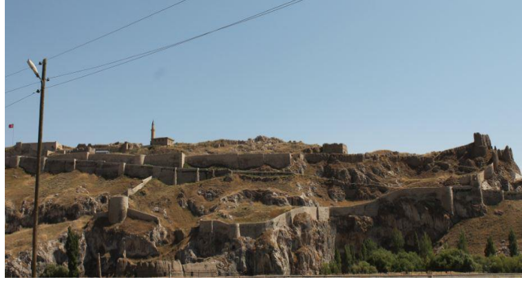
Fotoğraf 6: Katmanlar Halinde İnşa Edilen Van Kalesi Surları
