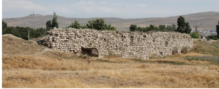
Fotoğraf 2. Taşla Örülen Van Kalesi Varoş Duvarları
