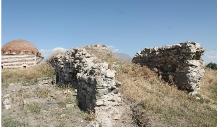
Fotoğraf 1. Ortada Kerpiç Duvar Kalacak Şekilde İçeriden ve Dışarıdan Taş ile Örülen Van Kalesi Varoş Duvarları
