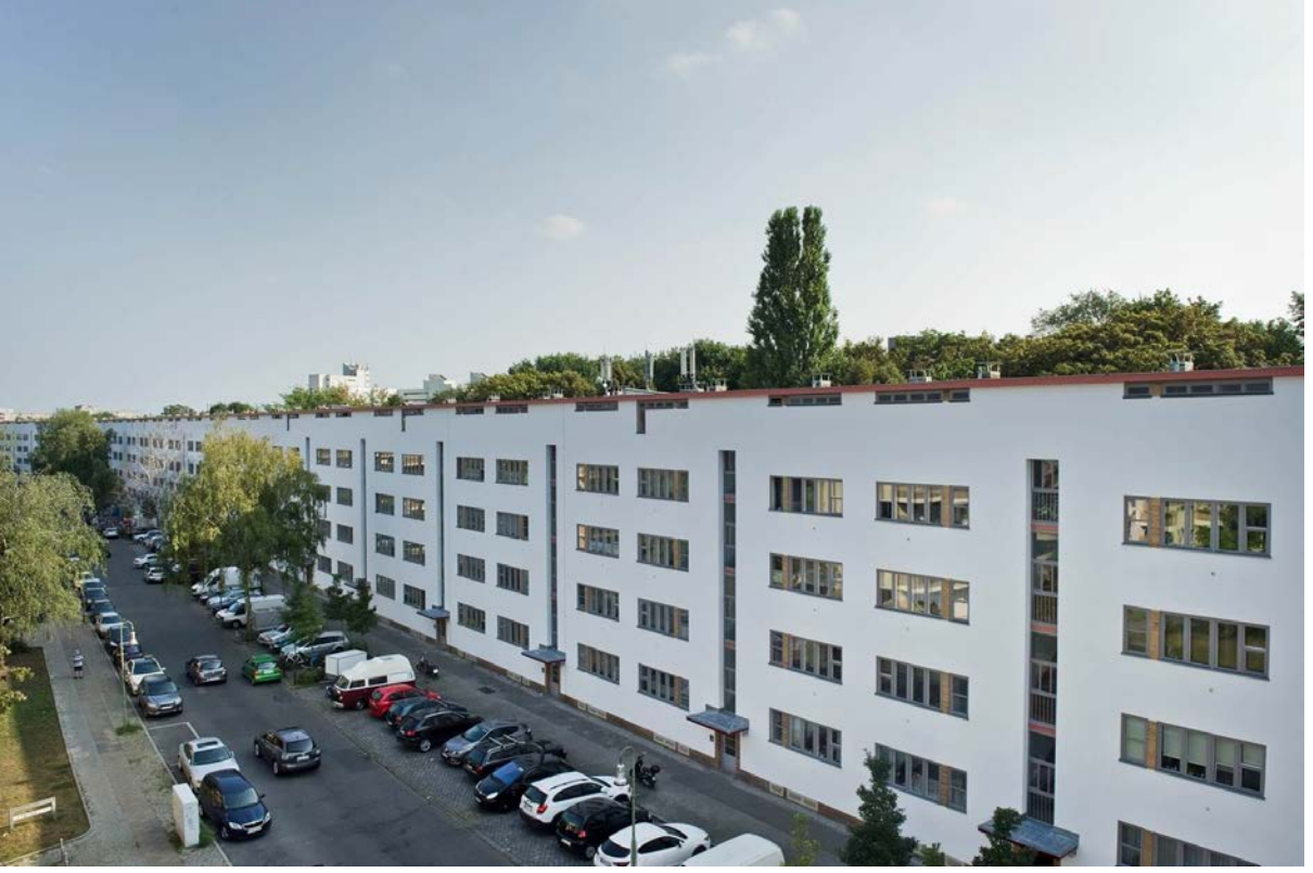
Şekil 6. Kuzey Cephe (URL-4).
