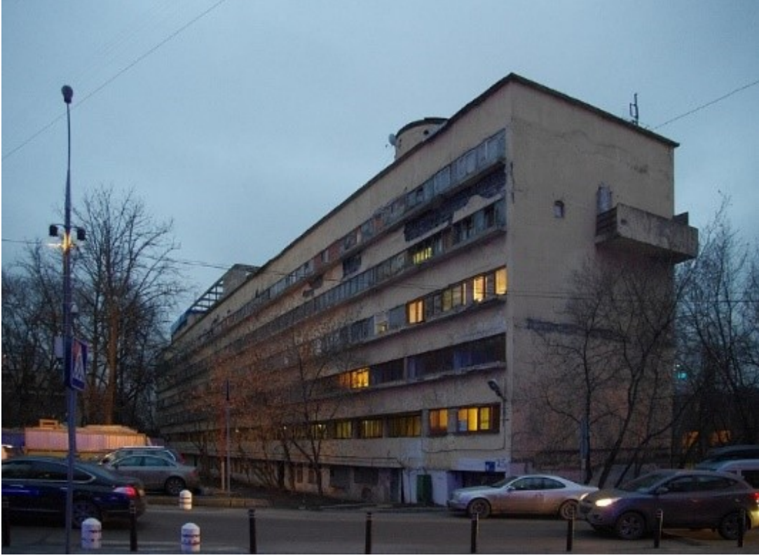
Şekil 14. Konut Bloku (restorasyon öncesi) (URL3).
