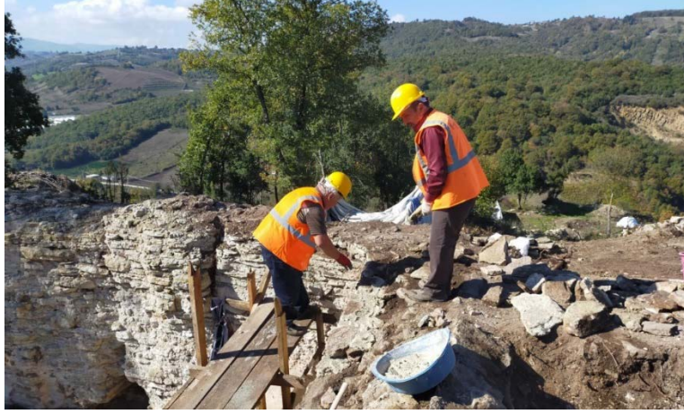
Şekil 12. Capping (şapkalama) uygulaması (Çobankale kazı arşivi).
