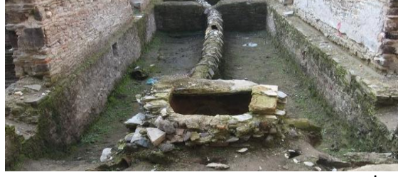
Foto 7. Zemin Kat Koridoru Altında Kalan Sistem (UDT İnşaat Arşivi)
