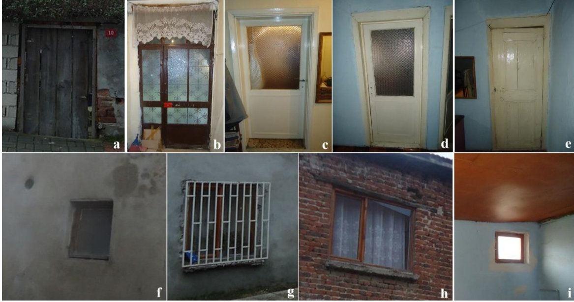
Foto 3. Konut mimari eleman görüntüleri (a) bahçe kapısı, (b) giriş kapısı, (c) zemin kat oda kapısı, (d) birinci kat oda kapısı, (e) üst kat tuvalet kapısı, (f) banyo penceresi, (g) salon penceresi, (h) üst kat oda penceresi, (i) sofa penceresi)
