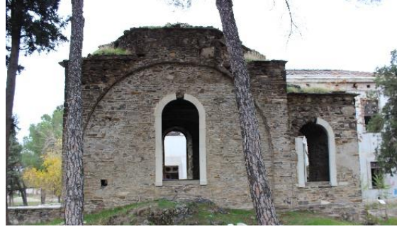
Foto 6. Okul bahçesinde yer alan Şapel yapısı (Yazar Arşivi-2021 Kasım)
