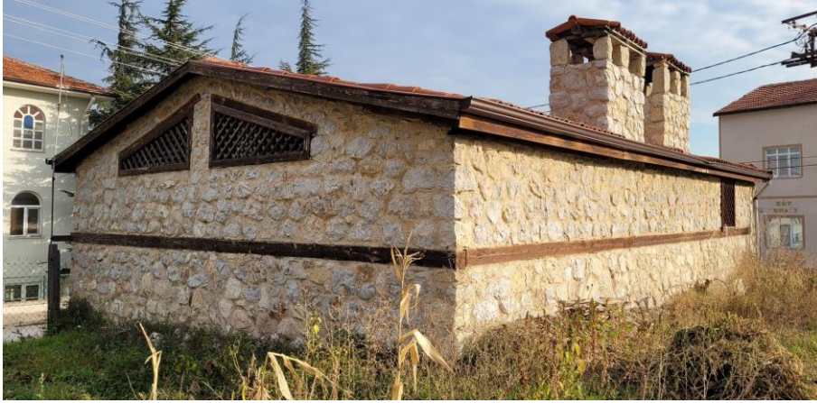
Foto. 10. Çamaşırhanenin güneybatı köşeden görünümü
