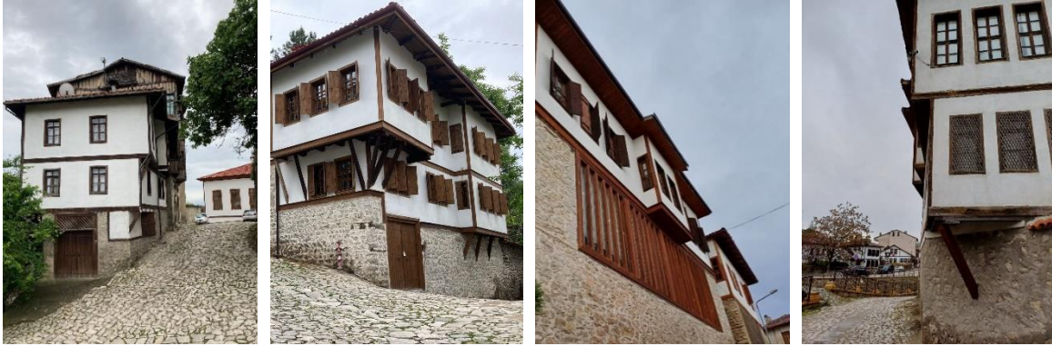
Şekil 12. Safranbolu Çarşı bölgesi konutlarında farklı türde çıkmalar a) Gönye çıkma, b) Köşe çıkma, d) Çıkma üstünde çıkma
