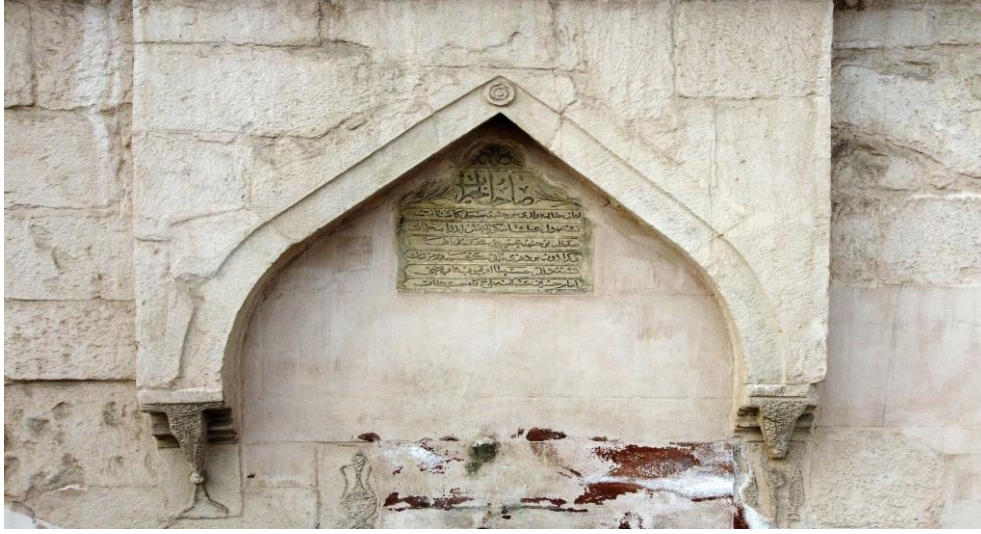
Foto. 13. Doğu cephe, güney kemer nişi
