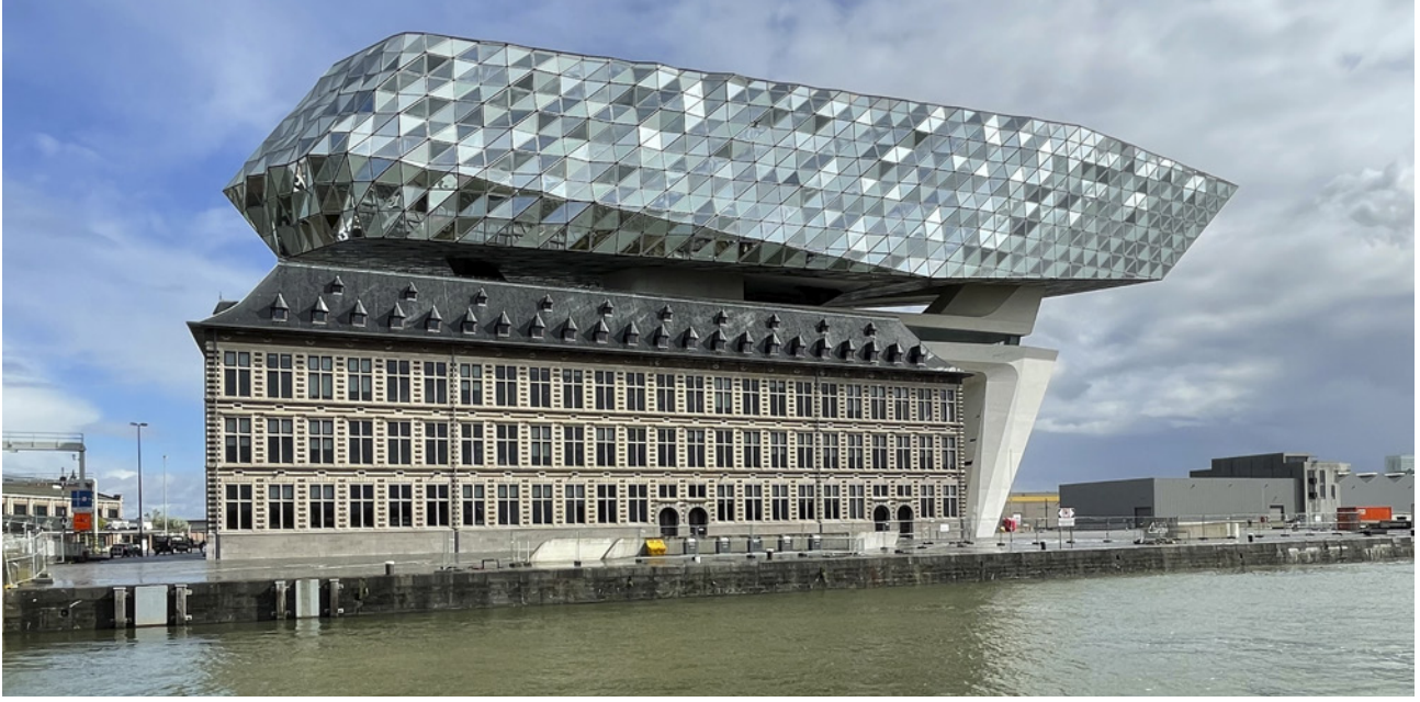
7 Zaha Hadid tarafından tasarlanan Port House (Liman Binası), Antwerp (Fotoğraf: Murat Gül)
