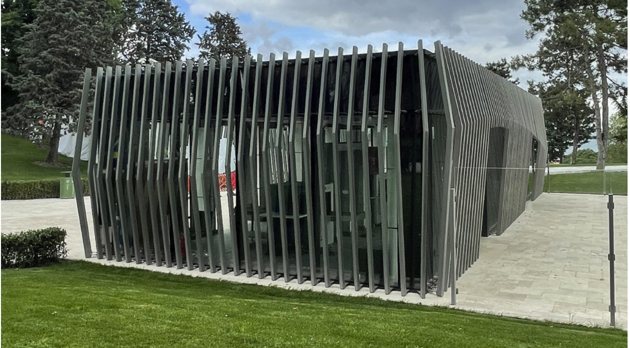
9-10 Güvenlik Kontrol Yapısı, Topkapı Sarayı Birinci Avlu (Fotoğraf: Murat Gül)
