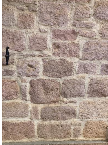
Şekil 8. Sarımsak taşı ile örülmüş duvar örneği (Kişisel Arşiv).
