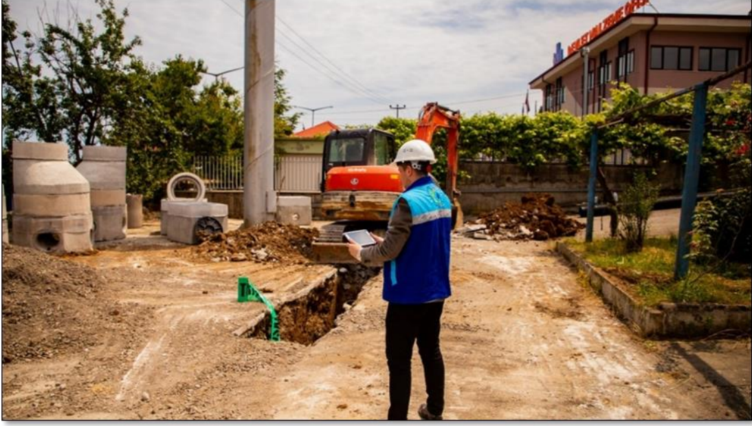
Şekil 7. Arıza sırasında mobil cihaz ile konum alımı
