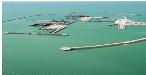
Şekil 1: Hazar denizinde petrol platformları modül ve altyapı ile yapay adaların inşaatı
