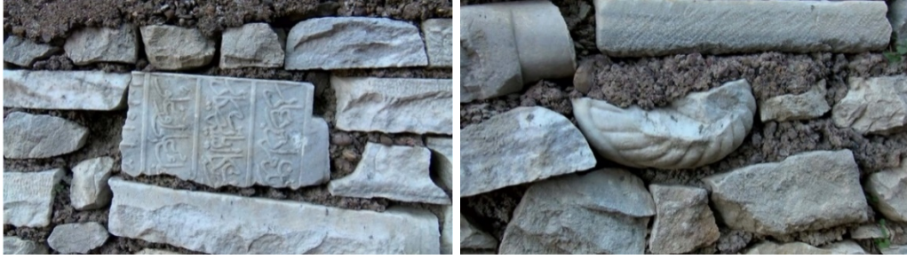
Fotođraf 90, 91: řile-avuş Mahallesi Mezarlıđı'nın Duvarları
