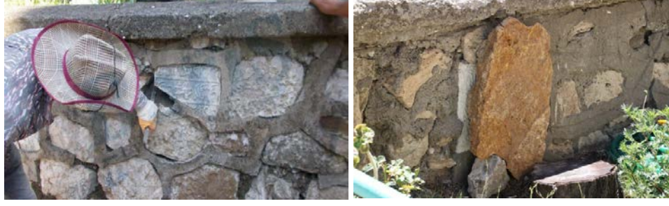
Fotođraf 88: İzmit-Bađçeşme Mezarlıđı'nda Duvar Yenileme alıřması Yapılırken, Duvar Tařı Olarak Kullanılan Tarihi Mezar Tařı Kitabeleri
