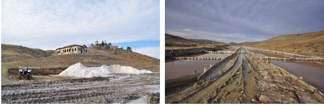
Fig. 5. Çukurköy Tuzlası idari binası ve tuz havuzları (Çorum İl Kültür ve Turizm Müdürlüğü Arşivi, Görsel: Bahadır TOMAY).
