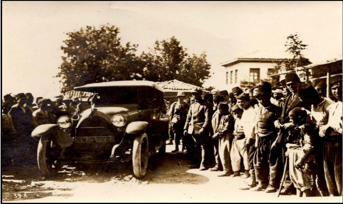
Bölge Halkının Durumu. Kaynak: Barış Eraşkın Özel Arşivi.
