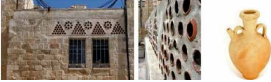
Görsel 16. Geleneksel mimari yapılar da terakota soğutma ve havalandırma (http 25).
