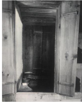
Şekil 9. Safranbolu evinde duvar mobilyaları içine gizlenmiş yıkanma alanları (Günay, R., 2004)
