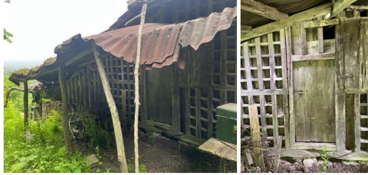
Şekil 15. Güney Cephesinde Bulunan Çatı Sundurması ve Çatı Girişi
