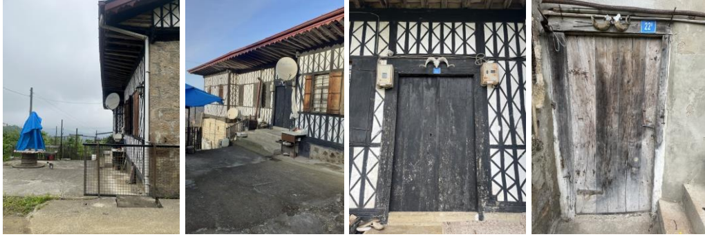
Şekil 20. Evin Batı Cephesinde Bulunan Ana Girişe Yaklaşım Yolu ve Avlu, Batı Cephesinde Bulunan Ana Giriş, Batı Cephesinde Yer Alan Ana Giriş Kapısı-Boğa Boynuzu ve Batı Cephesinde Bulunan Ahır Girişi-Boğa Boynuzu
