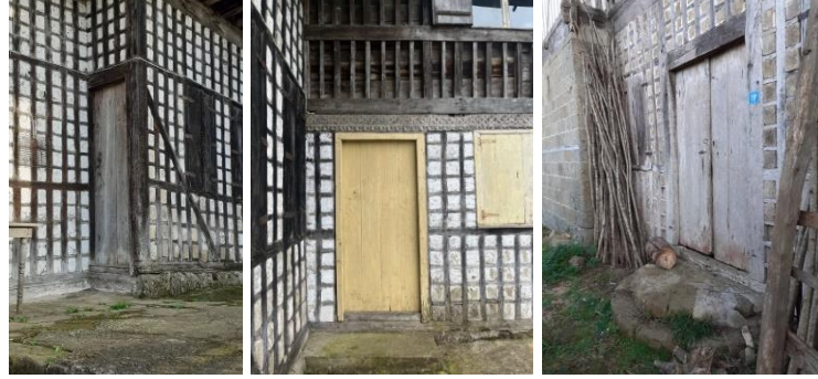
Şekil 13. Batı Cehesinde Bulunan Misafir Odası Girişi, Ek Yapı Girişi ve Kuzey Cehesinde Yer Alan Depo Girişi
