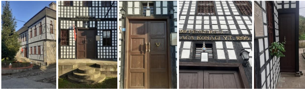
Şekil 7. Haşim Ağa Konağı'nın Batı Cephesinde Yer Alan Ana Girişe Yaklaşım Yolu, Batı Cephesinde Bulunan Ana Giriş, Ana Giriş Kapısı Üzerinde Yer Alan Süsleme-Aydınlatma Elemanları ve Batı Cephesi Misafir Odası Girişi
