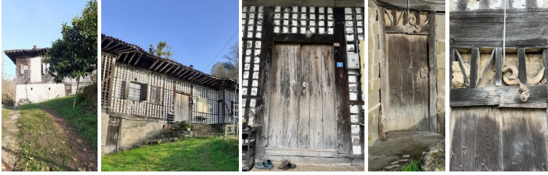
Şekil 12. Evin Batı Cehesinde Bulunan Ana Girişe Yaklaşım Yolu, Batı Cephesi Girişleri, Batı Cehesinde Bulunan Ana Giriş, Batı Cehesinde Yer Alan Ahır Girişi ve Ahır Girişinin Üzerinde Bulunan Boynuzu
