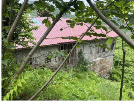
Şekil 18. Doğu Cephesinde Bulunan Ana Giriş (Solda) ve Ahır Girişi (Sağda)
