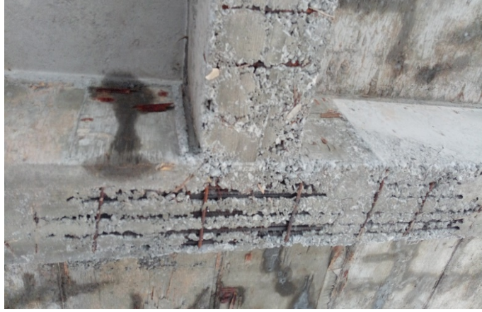
Şekil 6. Pas Payı Bırakılmayan Kiriş Betonu
