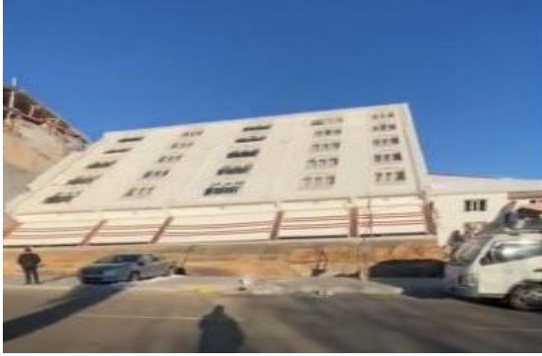
Şekil 1. Zemin Sıvılaşmasından Arkaya Yatan Bina (Adıyaman/Gölbaşı)
