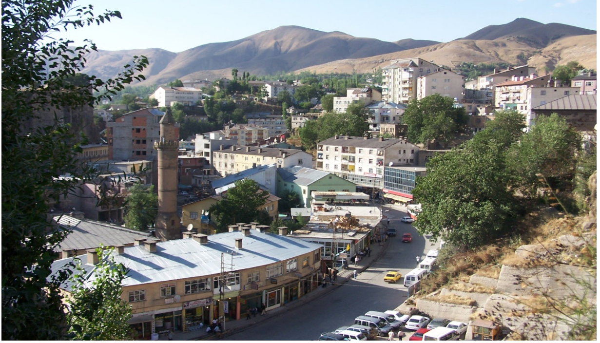
Res. 1: Bitlis Şehir İçi Dere Üzeri Betonarme Yapılaşma Genel Görünüşü (Ş. Öztürk, 2000).
