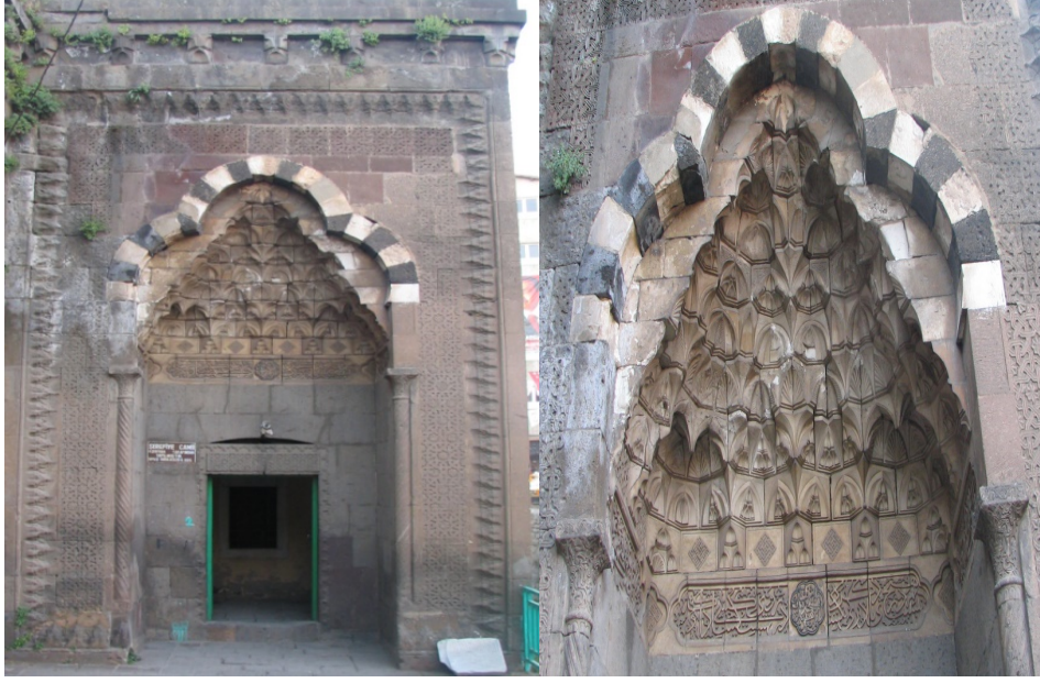
Res. 7-8: Şerefiye Külliyesi Giriş Kapısı Görünüşleri (Ş. Öztürk, 2021)
