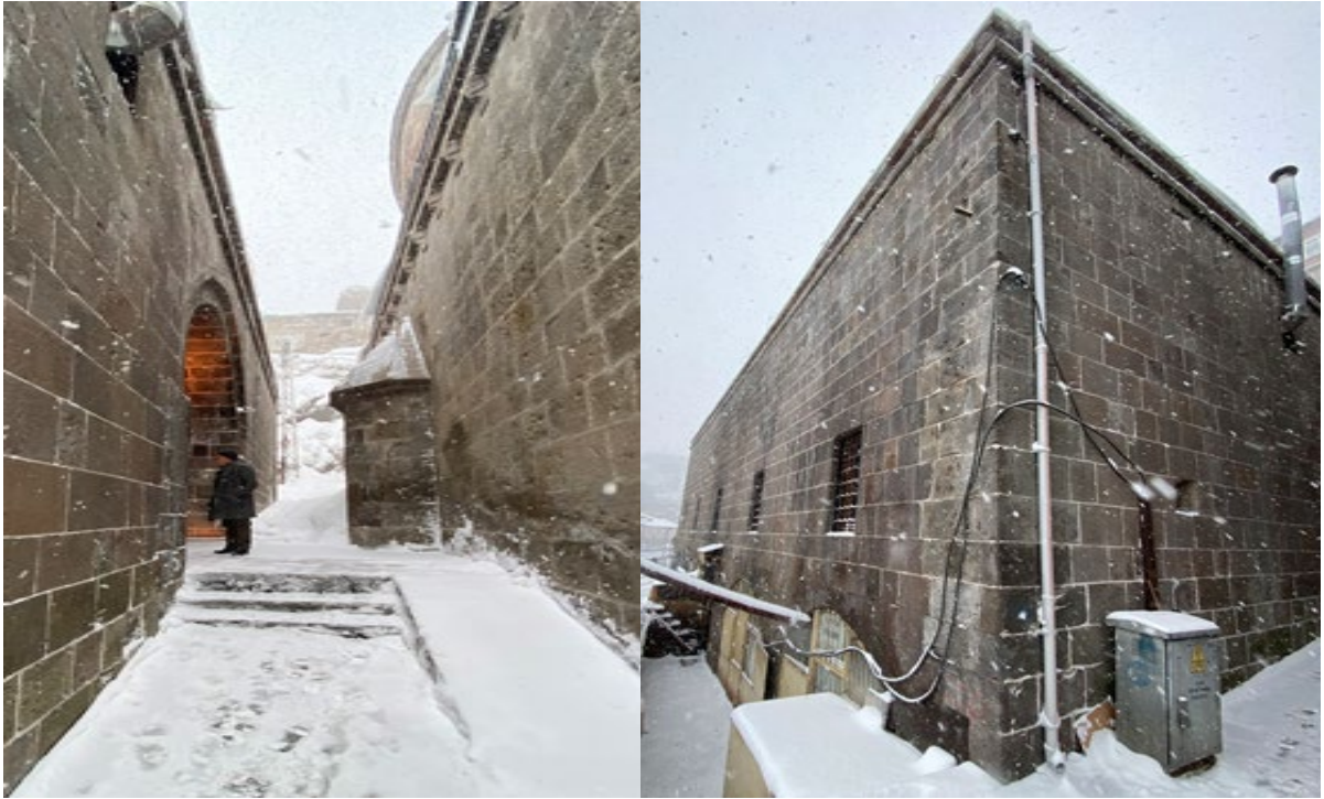
Res. 17-18: Şerefiye Medresesi Onarım Sonrası Doğu ve Kuzey Görünümleri (Ş. Öztürk 2022)
