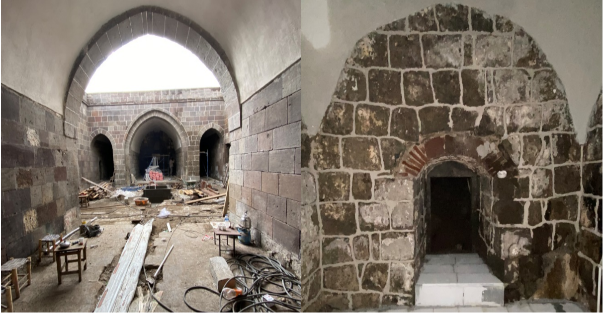
Res. 31-32: Şerefiye Medresesi İç Mekân Onarım Görünüşleri (Ş. Öztürk, 2021)
