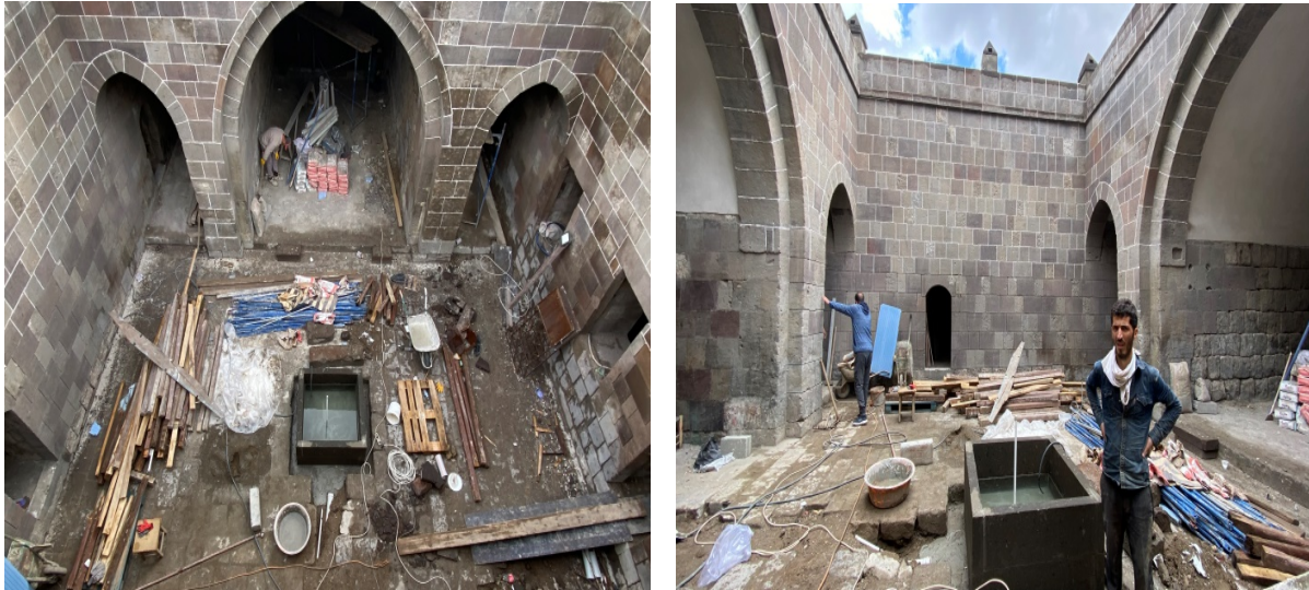
Res. 27-28: Şerefiye Medresesi Onarım Görünüşleri (Ş. Öztürk, 2021)
