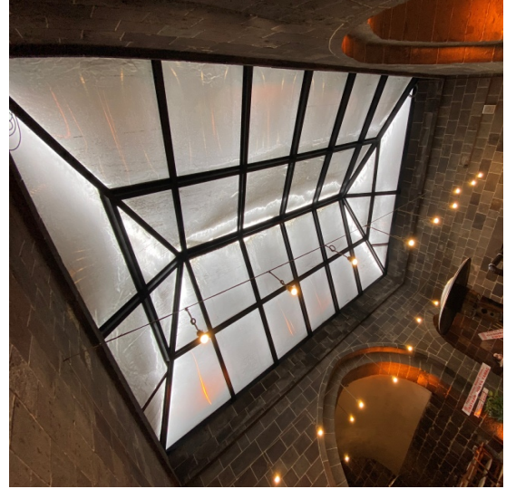
Res. 22-23: Şerefiye Medresesi Düz Dam Restorasyon Planı ve Aydınlık Feneri Görünüşü (Ş. Öztürk, 2022)
