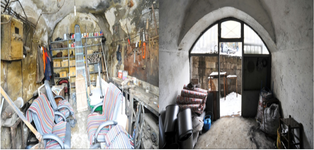
Res. 11-12: Şerefiye Medresesi Onarım Öncesi Dükkân İç Görünüşleri (Ş. Öztürk, 2011)
