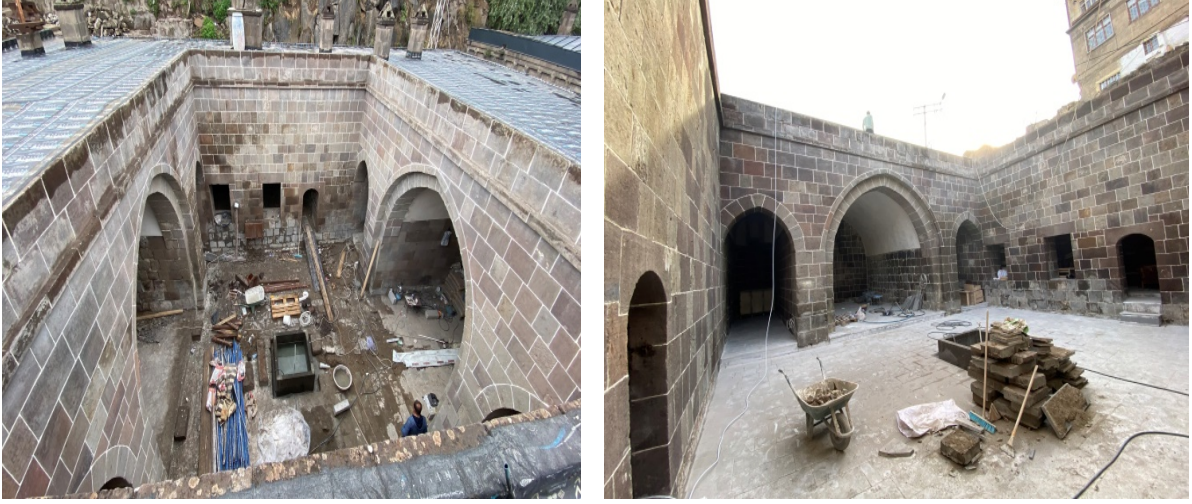
Res. 29-30: Şerefiye Medresesi Onarım Görünüşleri (Ş. Öztürk, 2021)
