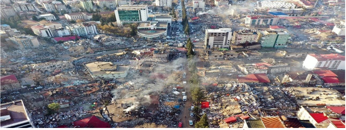
Fotoğraf 1. Deprem Sonrası Kahramanmaraş Dulkadiroğlu İlçesi Trabzon Caddesi
