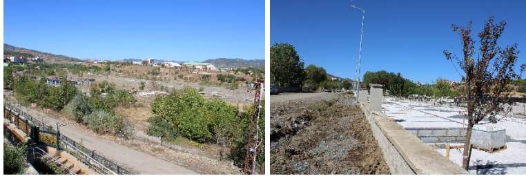
Şekil 8. Millet Bahçesi inşaatından kesitler
