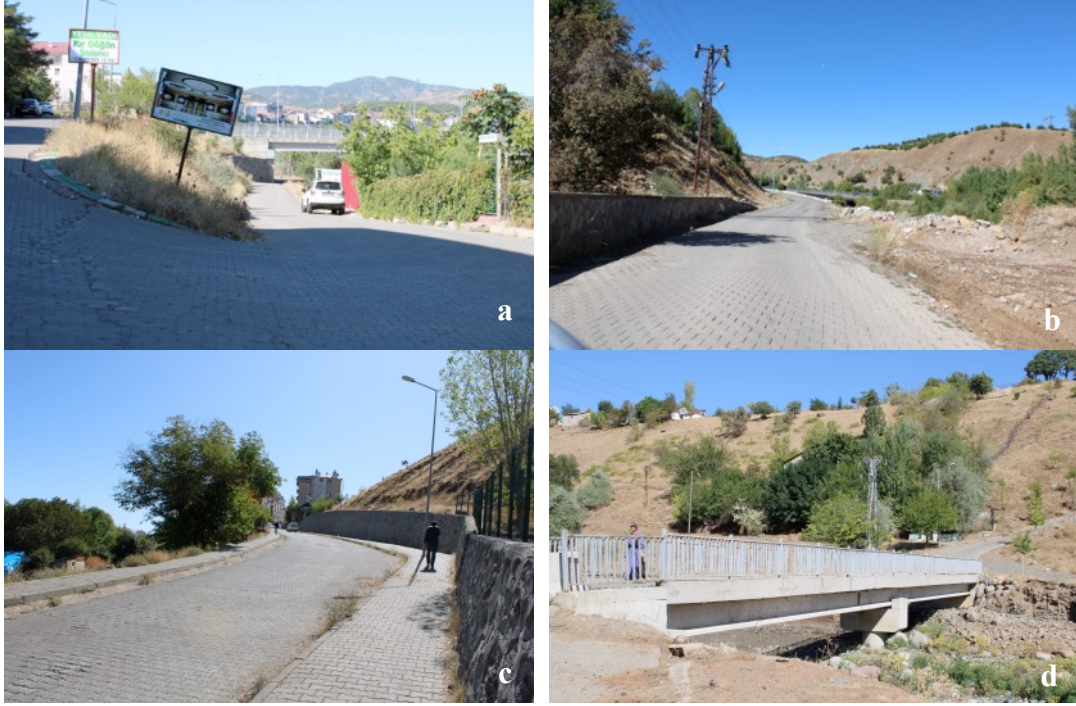
Şekil 3. (a) Kültür Mah. girişi, (b) A. Bazancir Köprüsü girişi, (c) Çarşı girişi, (d) Çapakçur yaya köprüsü
