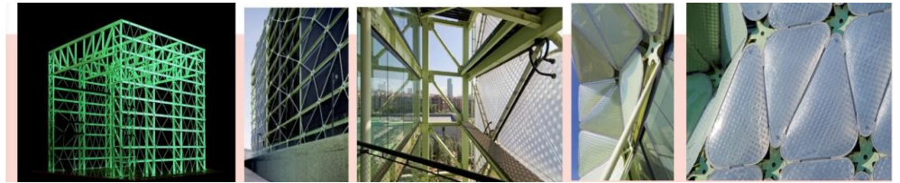
Şekil 24. ETFElerin asılacağı profil oluşturulması ile ETFElerin bağlantılarının yapılması için ve sis sağlayan boruların eklenmesi ( https://www.archdaily.com/49150/media-tic-enric-ruiz-geli )
