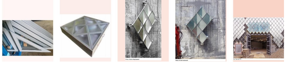
Şekil 15. Cephedeki cam kasetlerin üretilme ve montaj aşamaları ( https://www.arup.com/news-and-events/modularization-meets-variability-futurium-showcases-curtain-walling-of-tomorrow )
