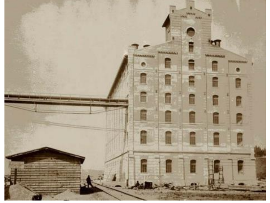
Şekil 10. Haydarpaşa Silolar, A Blok (URL.8)
