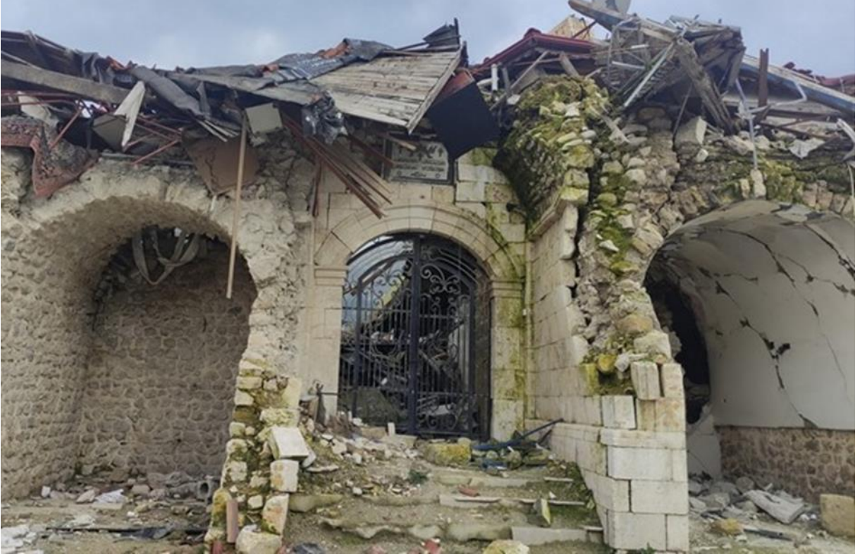
Resim 3. Deprem sonrasında üst katı göçen tarihi Ortodoks kilisesi enkazı
