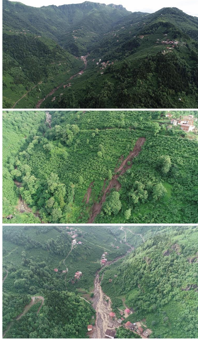
Şekil 3. Trabzon ili Araklı ilçesi Çamlıktepe mevkiinde gerçekleşen 2019 seli (DSİ, 2019).
