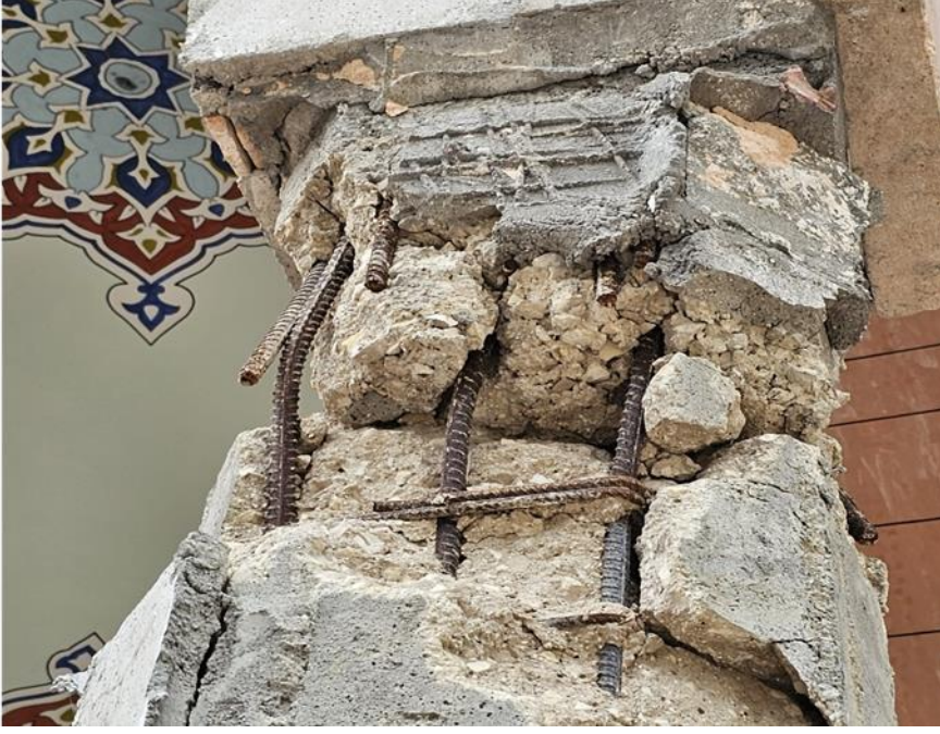
Resim 5. Kırıkhan'da yakın tarihte yapılmış bir camiden alınan kolondaki burkulan kolon donatıları
