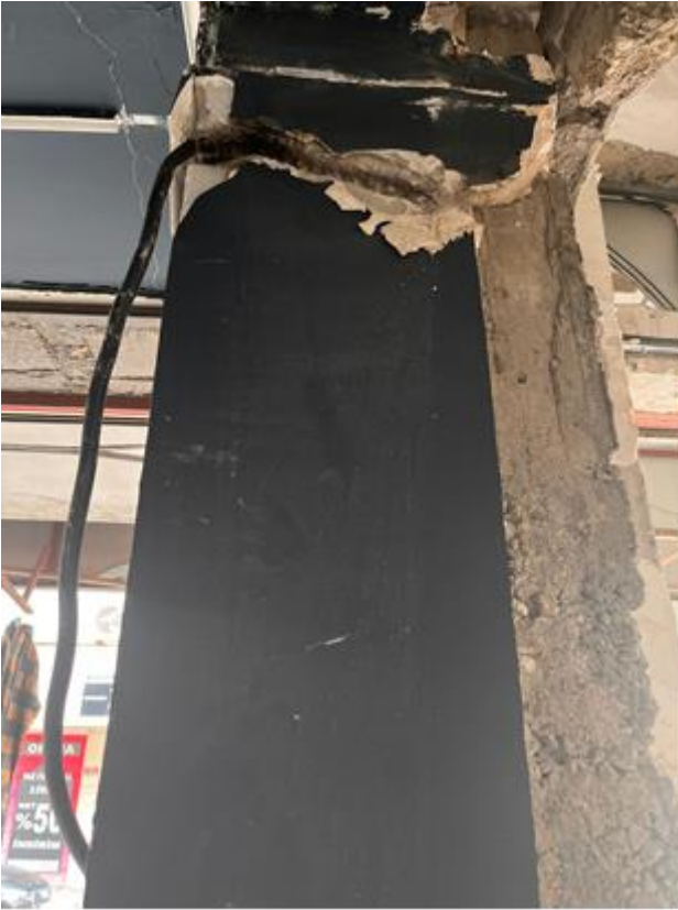
Resim 8. Kırılarak kesiti zayıflatılan, kablo geçirilmiş kolon
