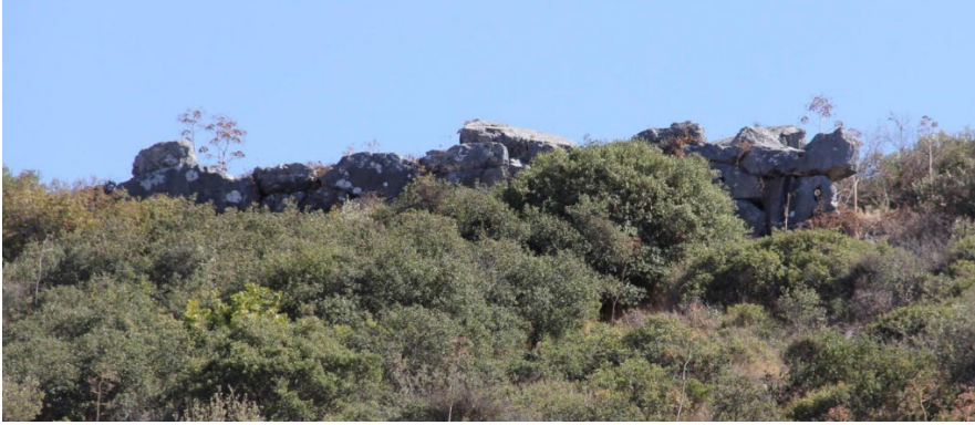
Fig.8: Ilıcatepe Sıtađeli'ni tüm yönlerden çevreleyen kyklobik sur duvarları.
