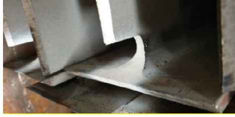
Şekil 2.5 - Kaynak erişim delikleri için penetrant test uygulaması.
