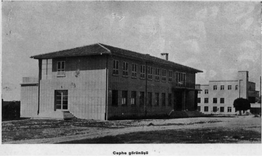
Şekil 16. Cerrahpaşa Hastanesi Poliklinik Binası. Kaynak: (Tomsu, 1941).
