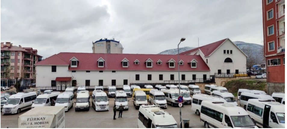
Şekil: 13 Doğu cephesi, 2022.
