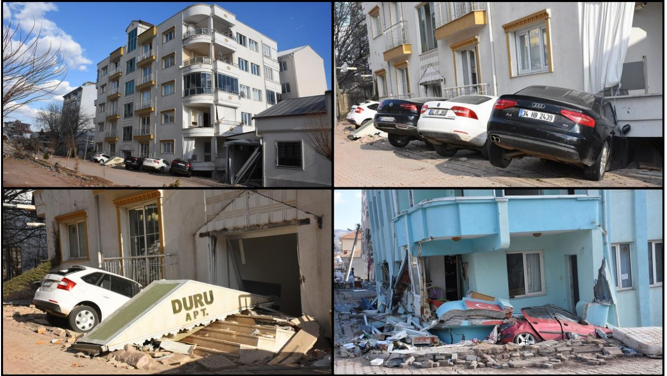
Şekil 14. Adıyaman'ın Gölbaşı ilçesinde sıvılaşma sonucunda zemine göçen binalar (URL-3).
