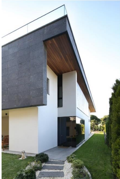
Şekil 5. Yapı cephesinde kaplama malzemesi olarak kullanılan bazalt taşı (Mert Uslu Mimarlık Arşivi)
