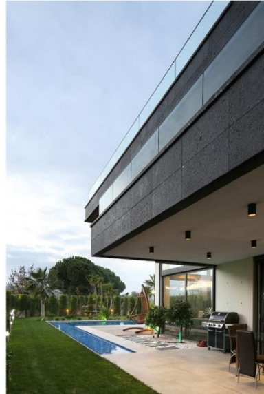
Şekil 5. Yapı cephesinde kaplama malzemesi olarak kullanılan bazalt taşı (Mert Uslu Mimarlık Arşivi)
