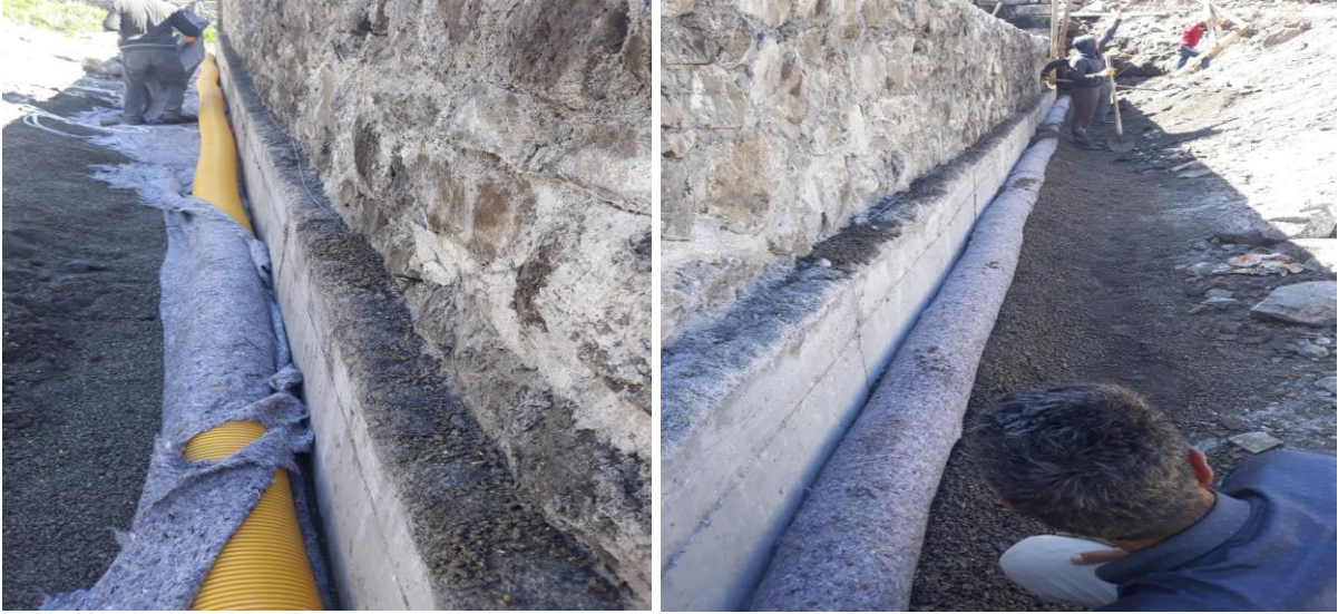
Şekil 42, 43. Mazlum Ağa Hamamı kapalı drenaj görünüşleri (Öztürk, 2019).
