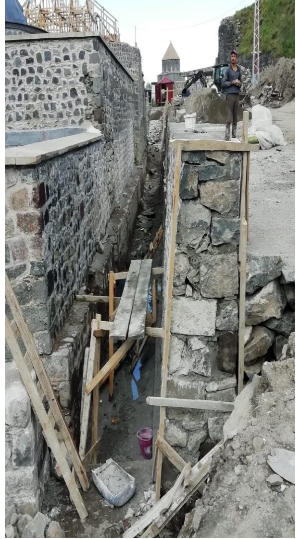
Şekil 44, 45. Mazlum Ağa Hamamı çevre güney istinat duvarı kesit detayı ve onarım görünüşü (Öztürk, 2019).
