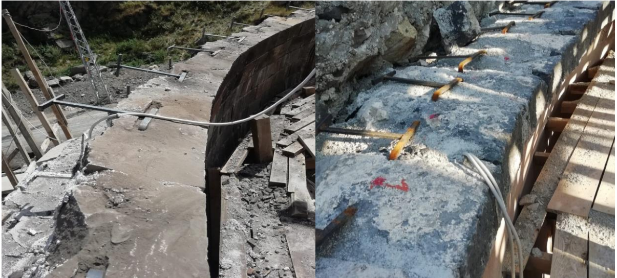
Şekil 36, 37. Mazlum Ağa Hamamı kubbe kasnak metal kenet görüntüleri (Öztürk, 2019).
