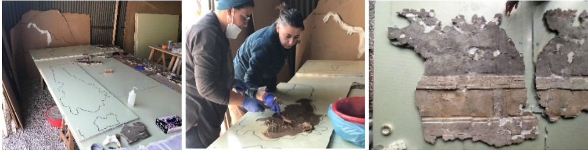
Görsel 11. Duvar resimlerinin taşıyıcı panellere aktarılması
