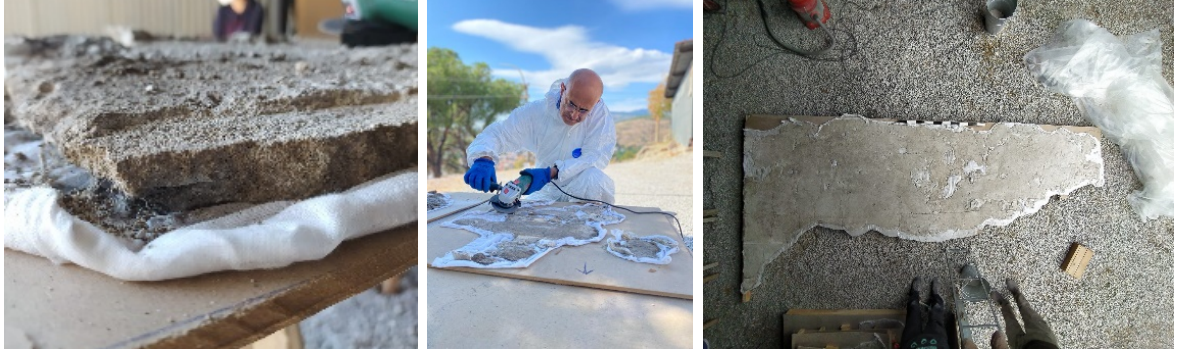
Görsel 8. Duvar resimlerinde arka harçların inceltilmesi çalışmaları
