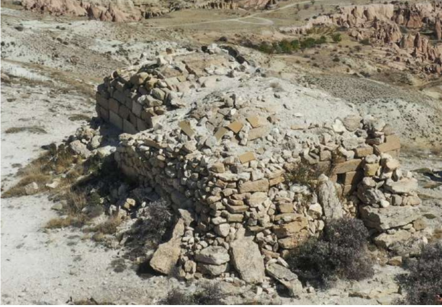
G. 10: Güneybatı cephe (E. Tokat, 2021)
