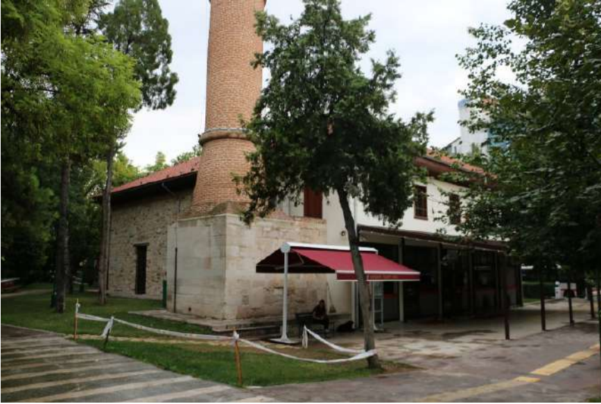
G. 9: Eskişehir Alâeddin Camii (A. Bekmez Yelen, 2016)
