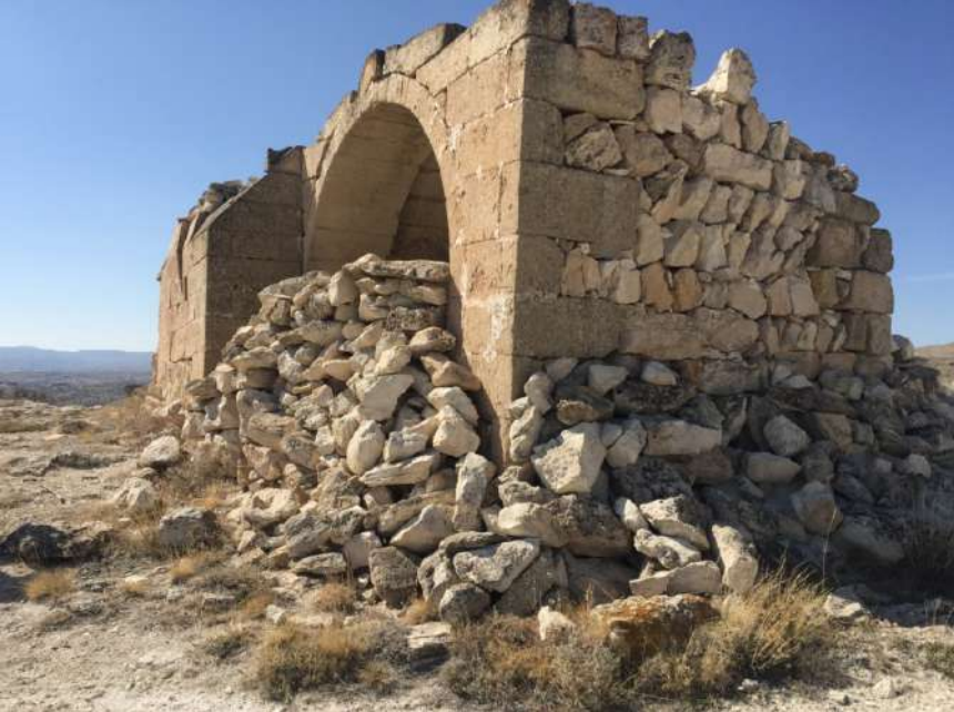
G. 11: Kuzeybatı cephe (E. Tokat, 2021)
