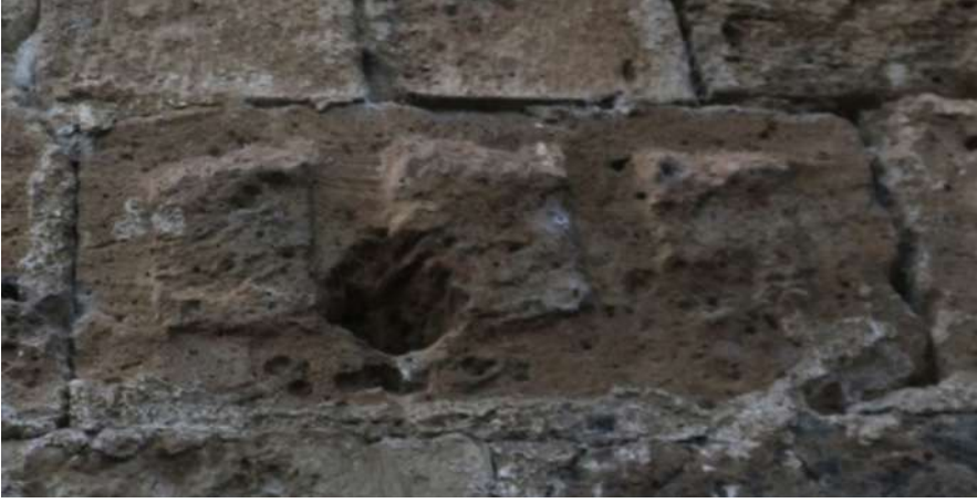
G. 8: Cami Doğu Cephesi 2 No.lu Taş (R. Yelen, 2024)
