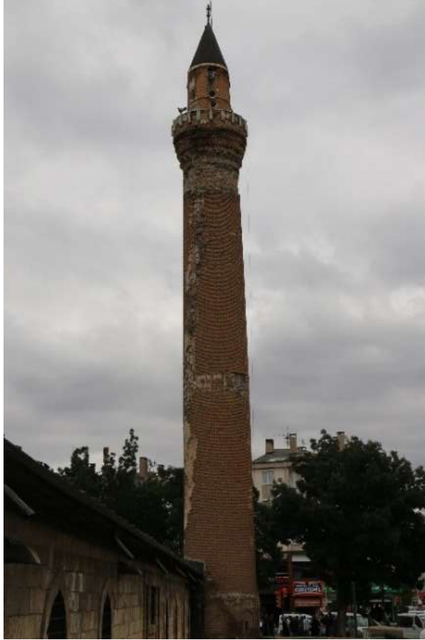
G. 16: Sivas Ulu Camii minaresi (A. Bekmez Yelen, 2020)
