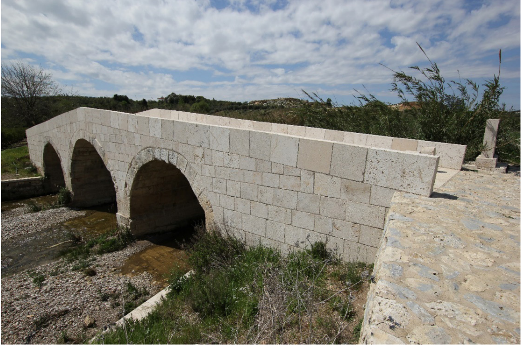
Resim 6: Köprünün restorasyon sonrası genel görünümü, güneydoğudan.
