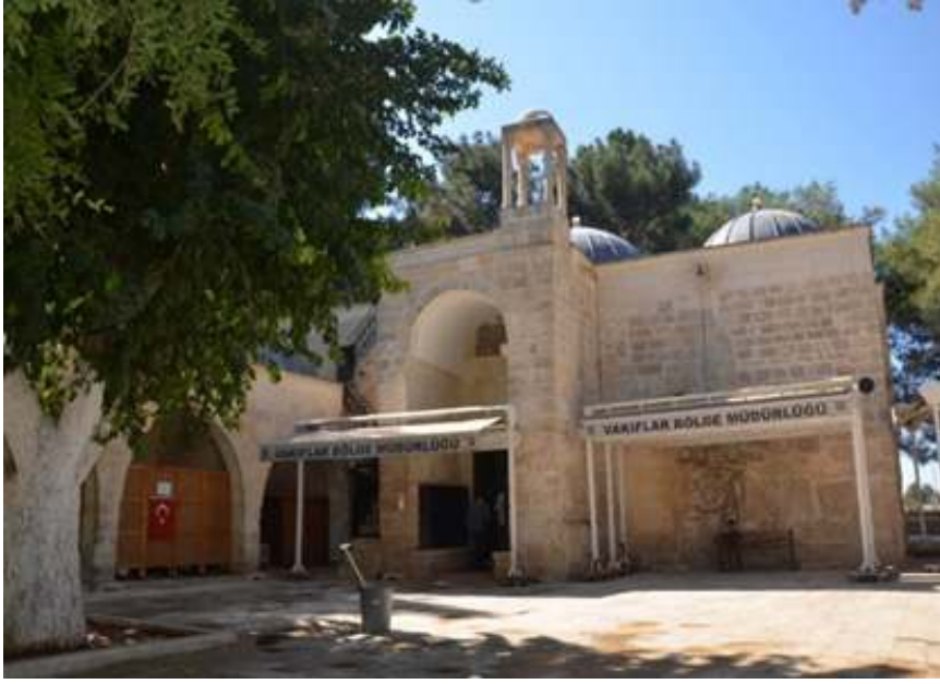
Fotoğraf 3: Şeyh Hayat el-Harrani Türbesi'nin doğu cephesinin görünümü, 2020. Foto. N. Kaya.
