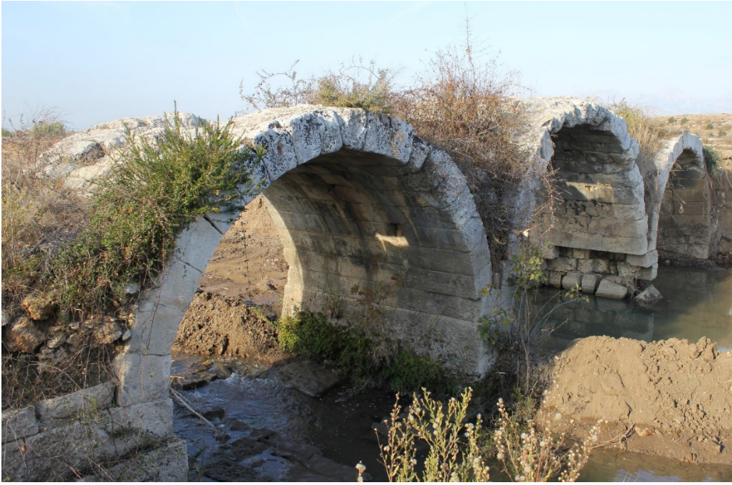
Resim 3: Köprü'nün restorasyon öncesi durumu.
