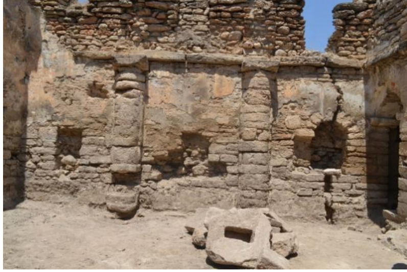
Foto 10. Habab/Havav(Surp Gatoğige) Kilisesi, kuzey duvarı taşıyıcı ve niş detayı. (K.Şen: 2020)
