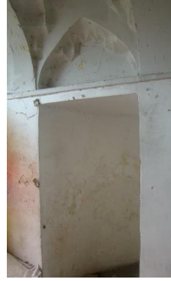
Foto 8. Oda girişlerinde başlayan mukarnas dizileri
