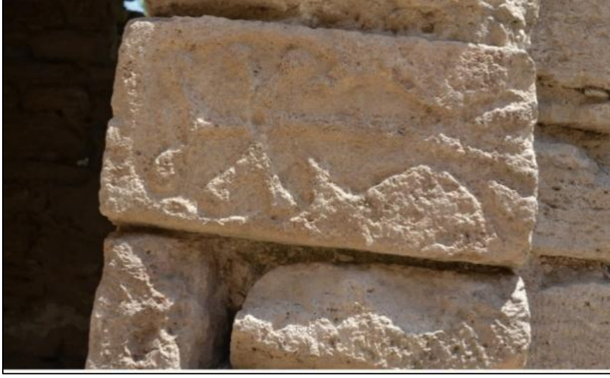
Foto 12. Surp Gatoğige Kilisesi, Kuzey Cephede Yer Alan Pastoforium Hücresi Giriş Duvarında Yer Alan Çatallı Haç Motifi.
