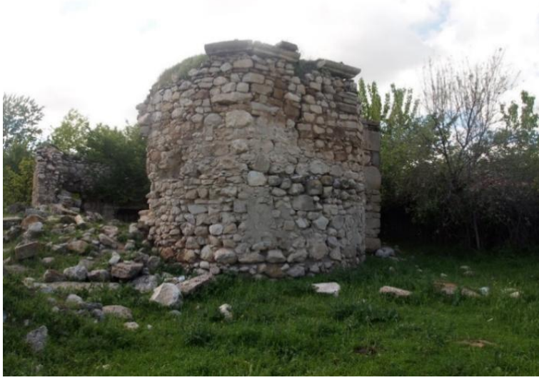
Foto 19. Surp Kevork Kilisesi, Genel Görünüşü.
