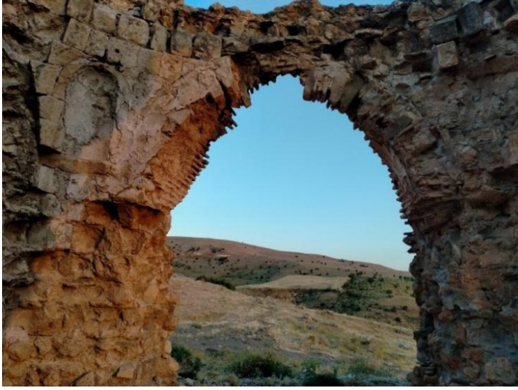
Foto 17. Surp Asdvadzadzin, Çakırkaş (Hoşmat) Kilisesi, güney duvarı içten görünüşü.
