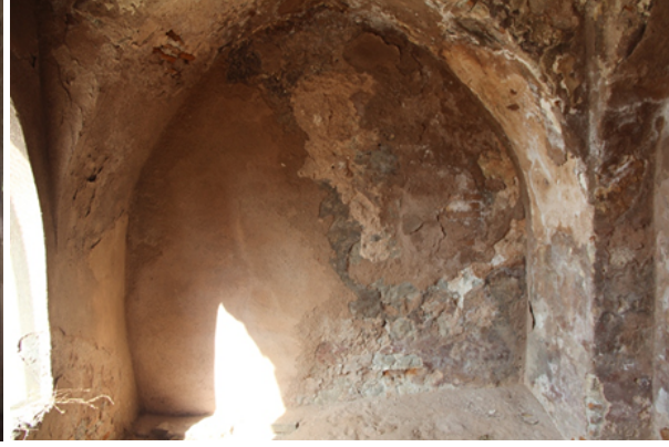
Şekil 12. Soğukluk kuzey duvar
