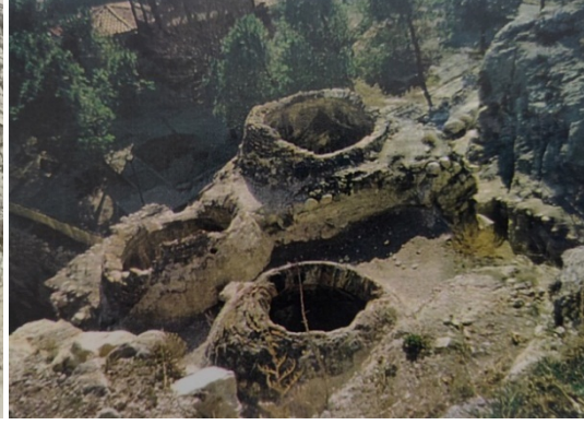
Şekil 27. Onarım öncesi üst örtü
