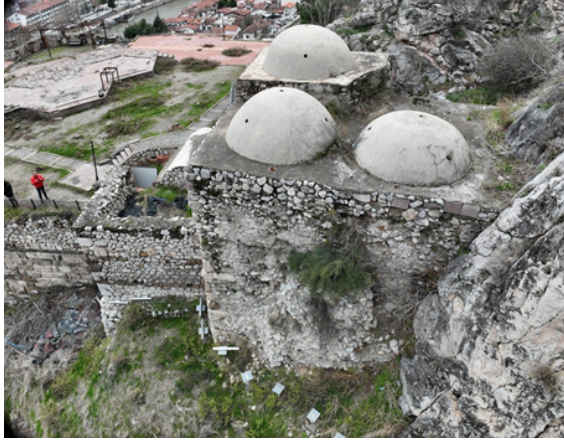
Şekil 5. Doğu ve kuzey cephe
