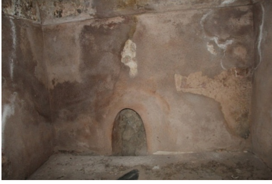
Şekil 15. Ilıklık doğu duvarı
