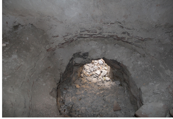
Şekil 22. Sıcak su deposu
