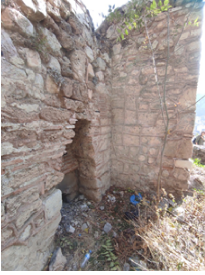
Şekil 9. Batı cephe külhan
