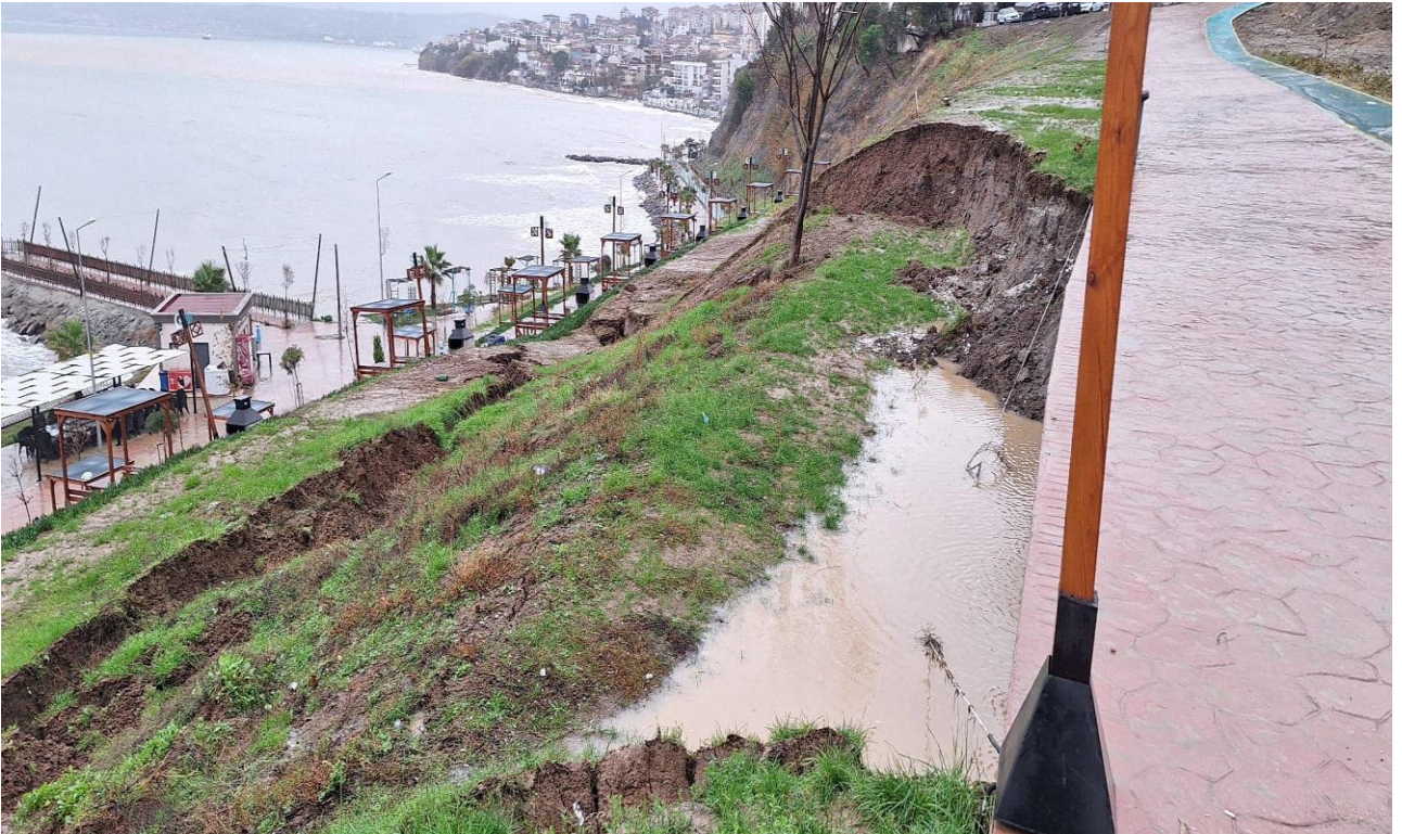
Şekil 10. Alkaya heyelanının meydana geldiği yamaç arazide yağışlarla gelen suyun şev diplerinden sızması, alttaki anakayanın su içeriğinin artmasına ve sürtünmenin azalarak heyelanın oluşmasına sebebiyet vermiştir (Gence, 2023)
