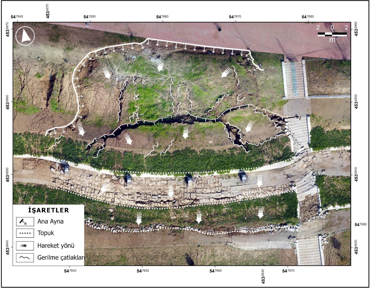
Şekil 3. İnceleme alanındaki Alkaya heyelanının orto-foto görüntüsü
