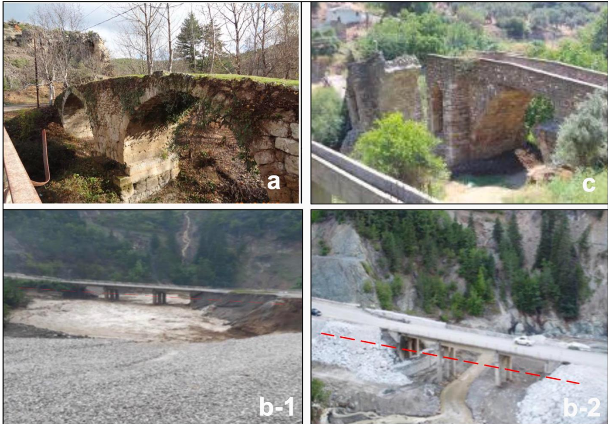
Figure 2. a) Konarı Bridge (Karabük) [25], b-1,2) İkiçay Bridge (Kastamonu) [25], c) İkiçay Bridge (Aydın) [25]
